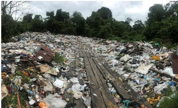
Acceso al frente de trabajo
