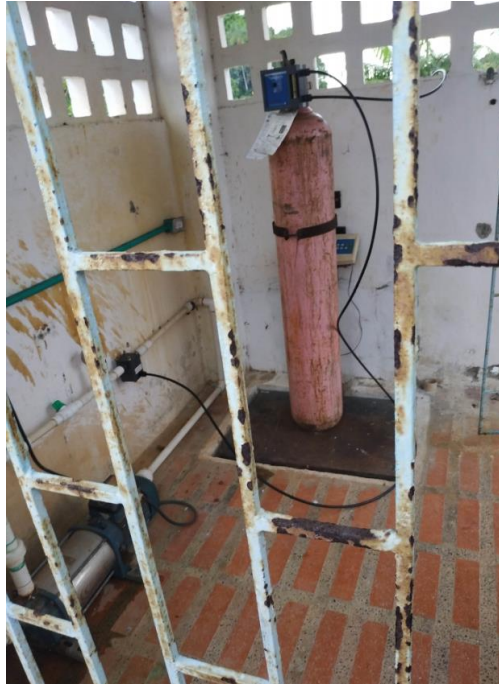
Imagen 11. Sistema de desinfección con cloro gaseoso
