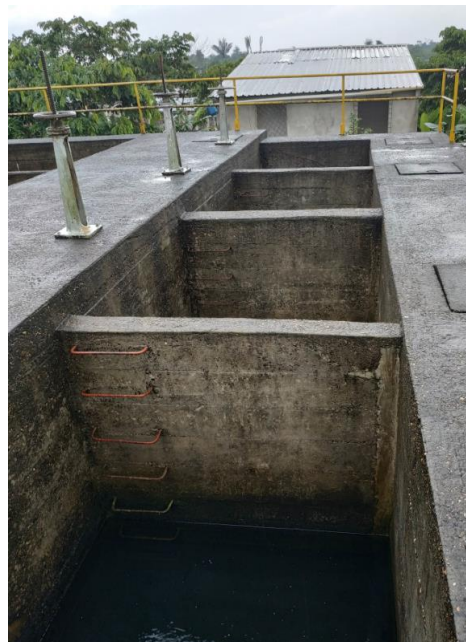
Imagen 10. Filtros de antracita en la planta
