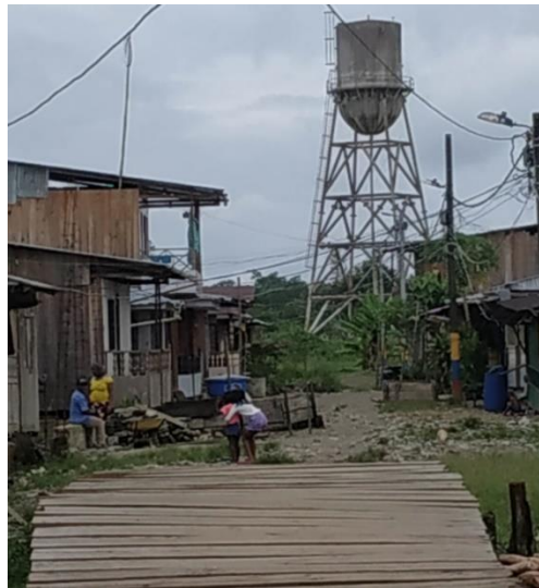
Imagen 19. Taque de almacenamiento elevado barrio Santa Bárbara
