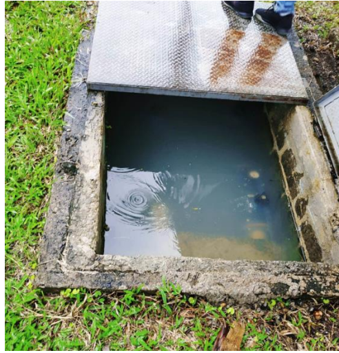
Imagen 5. Macromedidor de llegada a la planta
