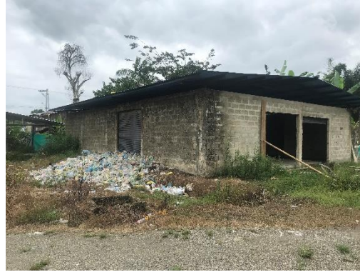
Infraestructura en construcción para acopio y clasificación de material
