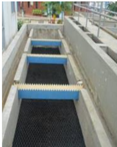
Sistema de Sedimentación
