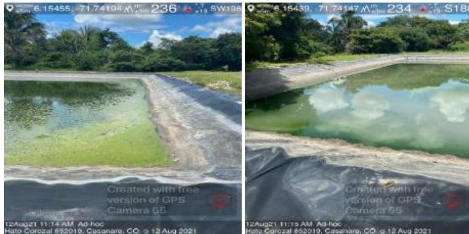
Figura 19. Laguna de estabilización
