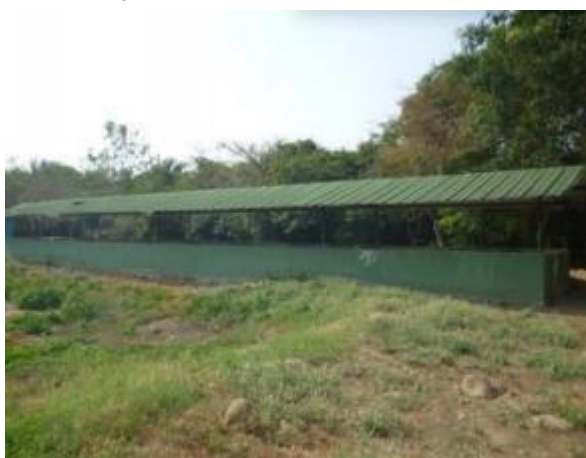
Figura 21. Lechos de secado de lodos
