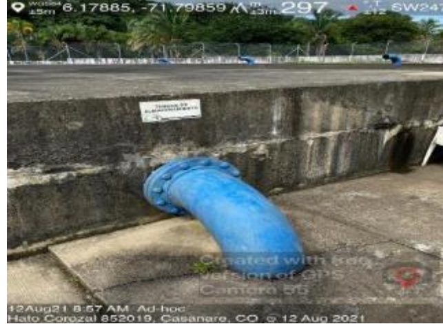
Figura 10. Tanque de almacenamiento de agua tratada
