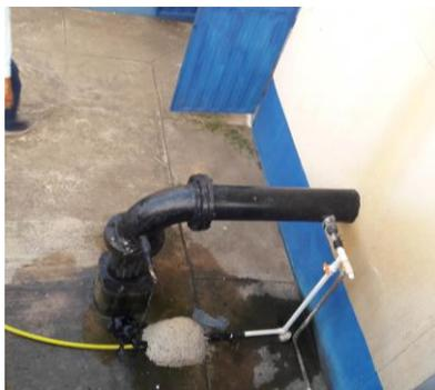
Fugas líneas de salida tanque de 200 m<sup>3</sup>
