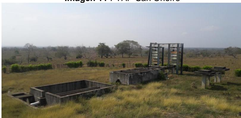
Vista general de la PTAP (torres de aireación, floculador, decantador), abandonada y fuera de operación
