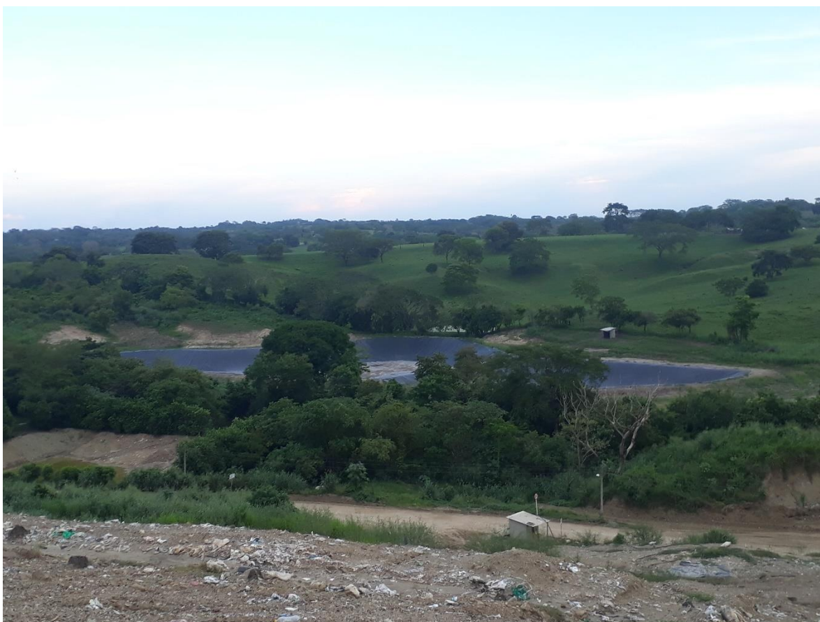
Imagen 117. Construcción de pondajes de lixiviados
