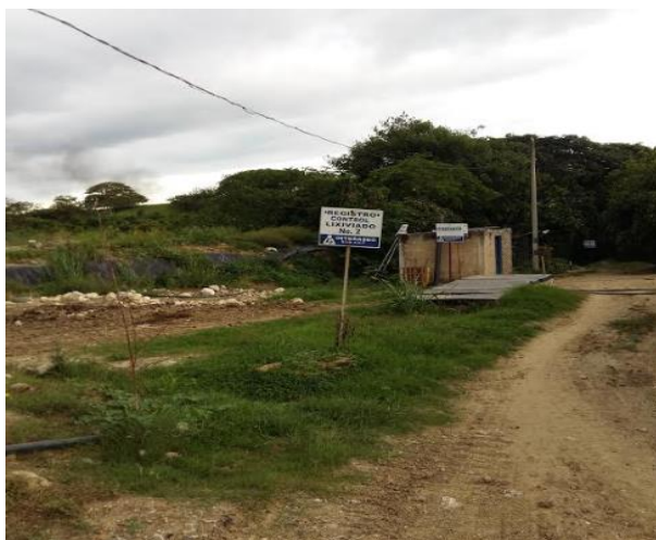
Imagen 110. Zona de registro y control de lixiviado
