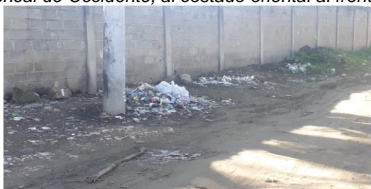
Imagen 68 Punto crítico Troncal de Occidente, al costado oriental al frente de Torcoroma.
