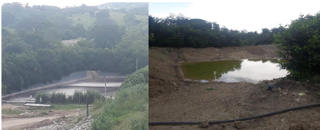
Imagen 111. Piscinas de lixiviados
