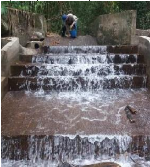
Captación quebrada La Tigra
