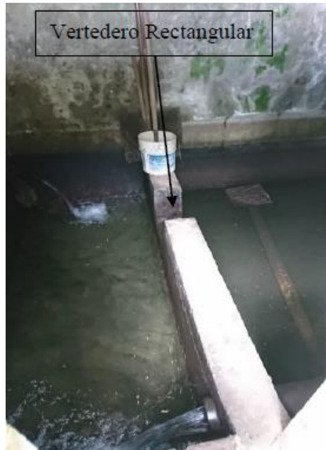
Vertedero quebrada La Amalia Fuente: A.A.S. S.A. E.S.P.
