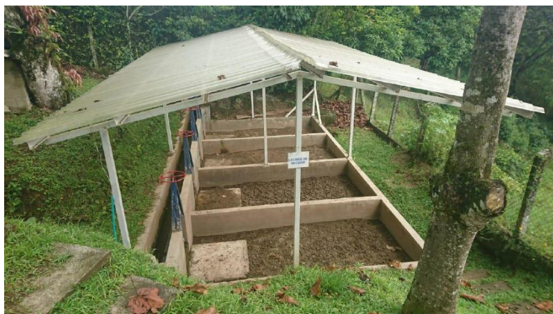
Imagen 8. Lechos de secado de lodos.
