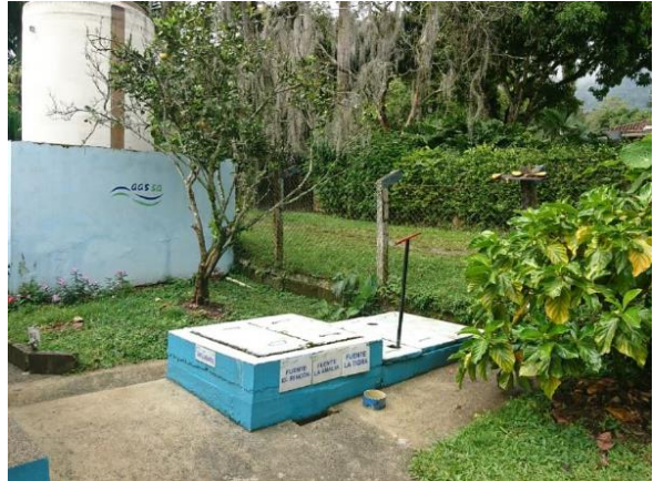
Cámara de entrada
