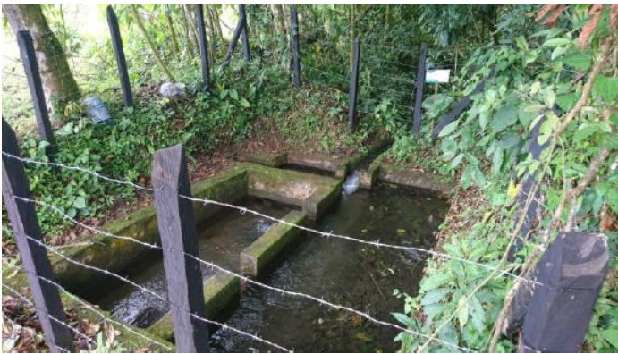
Captación y desarenador quebrada El Rincón
