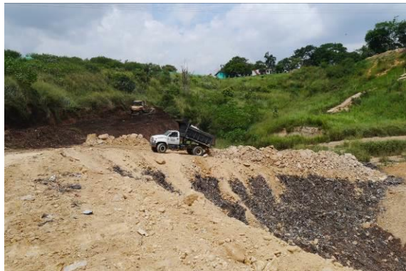
Foto 34. Construcción de vía para ingreso parte alta
