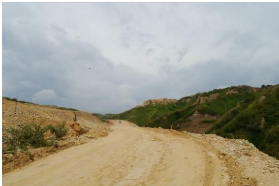
Foto 29. Vía que conduce al frente de trabajo
