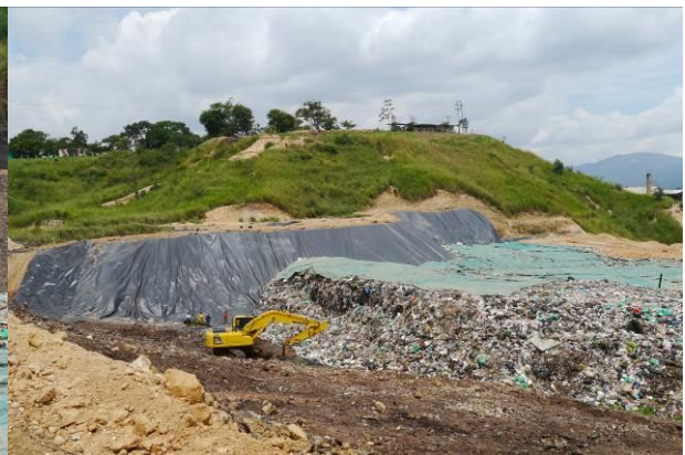
Foto 47. Retroexcavadora extrayendo material
