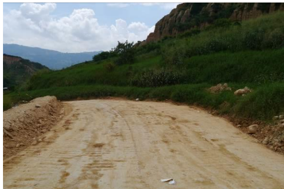
Foto 30. Vía que conduce al frente de trabajo
