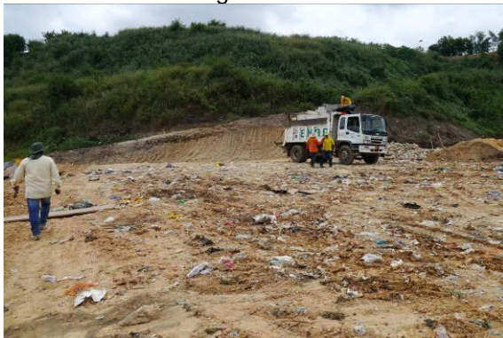
Foto 33. Estado Vía de ingreso al frente de descarga
