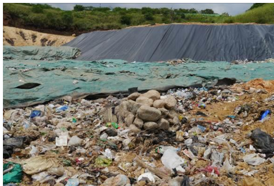
Foto 59. Chimenea a la altura del gavión
