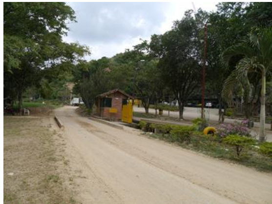
Foto 26. Estado de la vía que conduce a la báscula de pesaje
