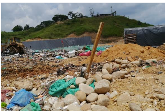
Foto 58. Chimenea que ha perdido su posición vertical
