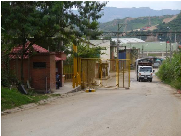
Foto 35. Portería de acceso
