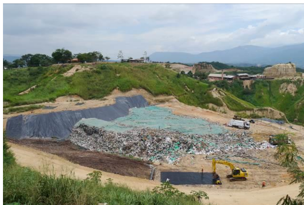
Foto 48. Retroexcavadora en postura de geomembrana
