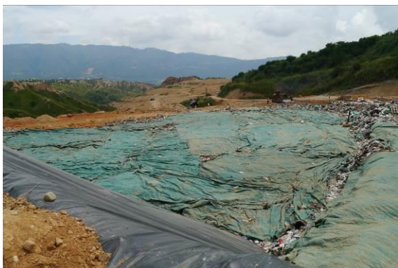
Foto 49. Vista general coberturas vaso activo
