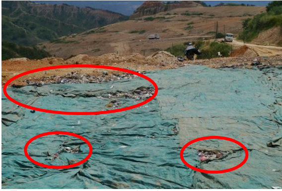
Foto 51. Vista general coberturas vaso activo
