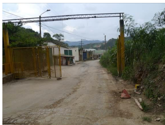
Foto 24. Estado de la vía al ingreso
