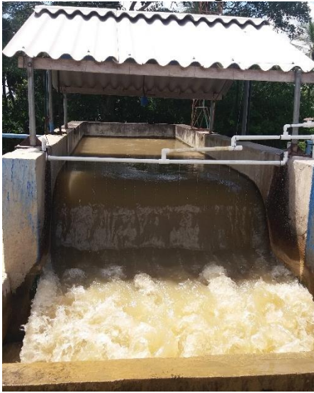
a) Estructura de entrada a la PTAP
