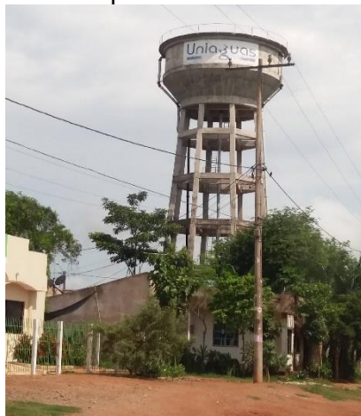
Imagen 15. Tanque de almacenamiento Sahagún.
