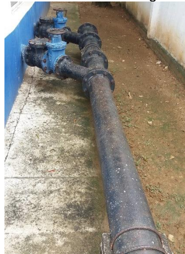
b) Tuberías de impulsión
