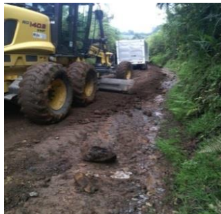
Tractor – adecuación vía
