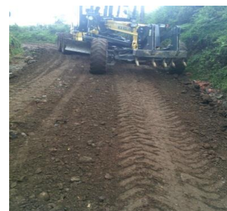
Tractor – adecuación vía
