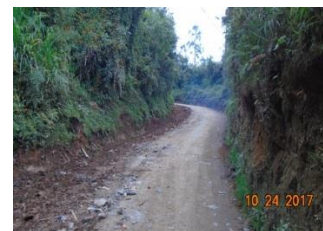
Vía de la vereda Alto Grande
