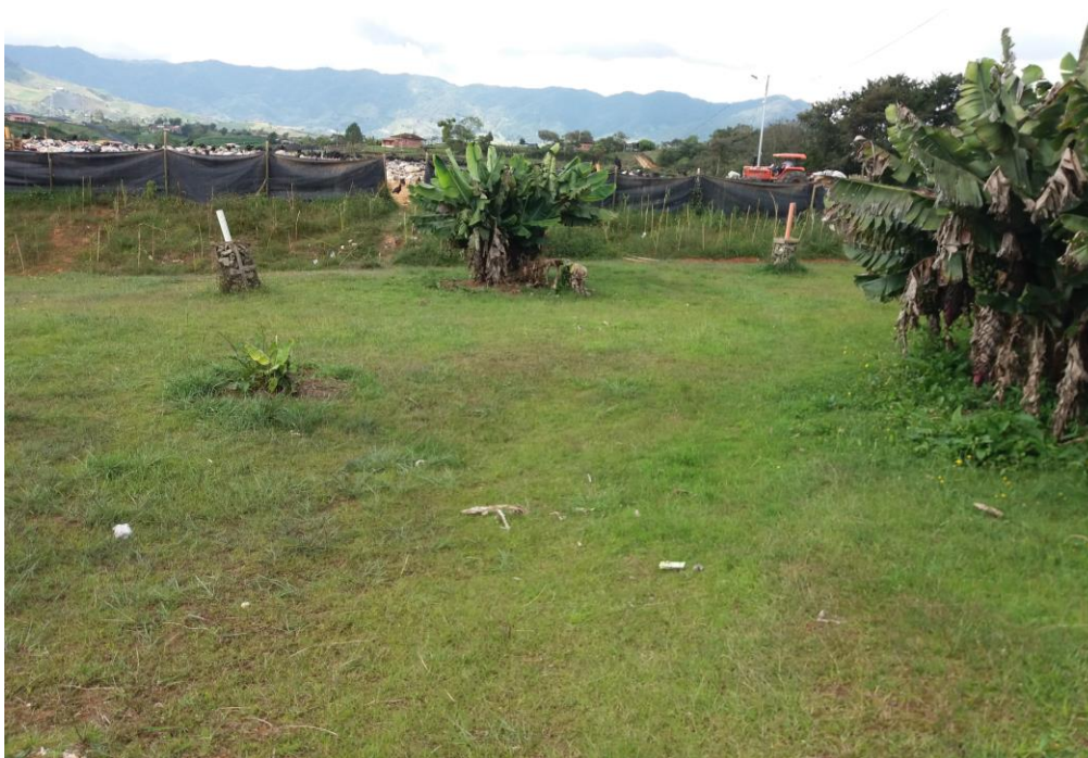
Imagen 12. Celda 1 clausurada con cobertura vegetal y chimeneas
