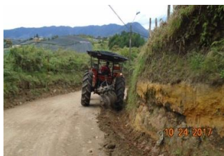
Tractor – adecuación cunetas
