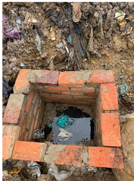
Ilustración 20. Caja recolectora de lixiviados
