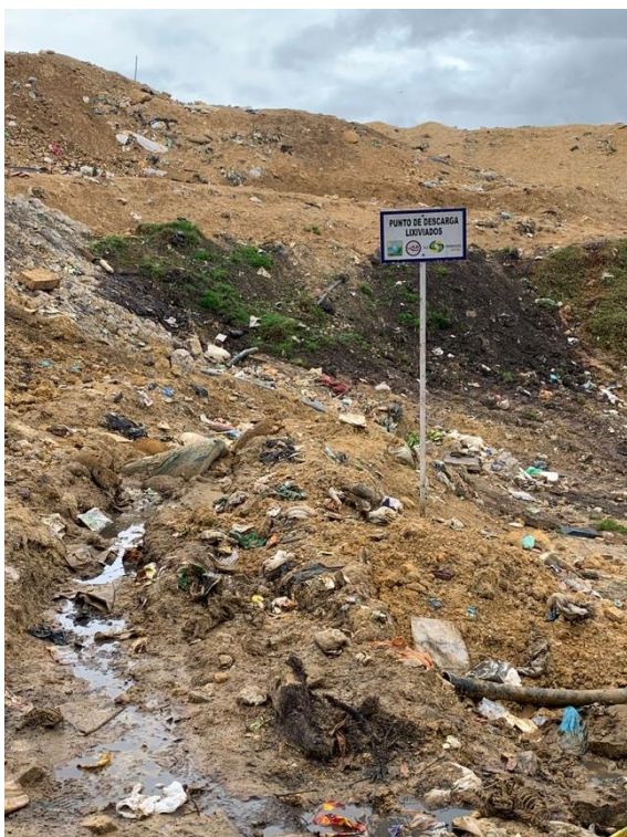
Ilustración 19. Zona de descarga de lixiviados
