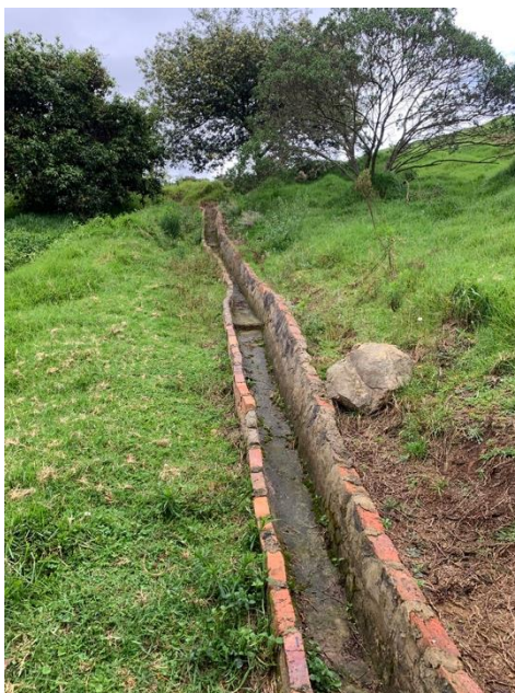
Ilustración 21. Canales de agua lluvia
