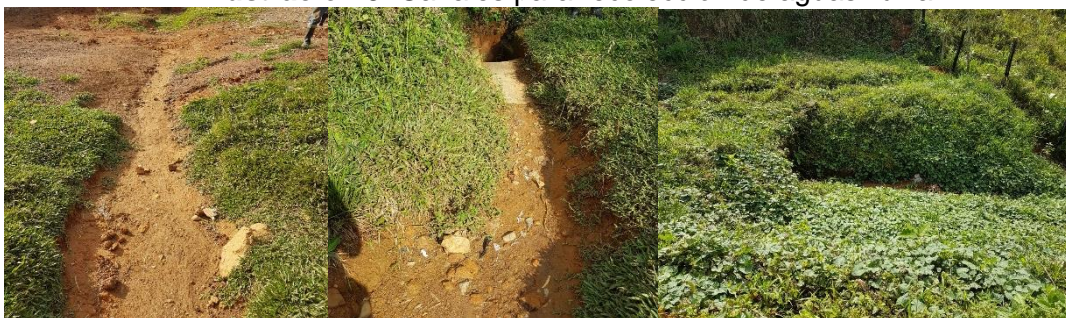
Ilustración 9. Canales para recolección de aguas lluvia
