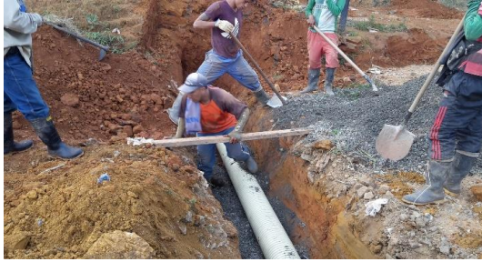
Instalación de tubería de drenaje aguas lluvias
