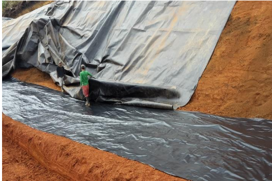
Instalación de polietileno para protección de geomembrana
