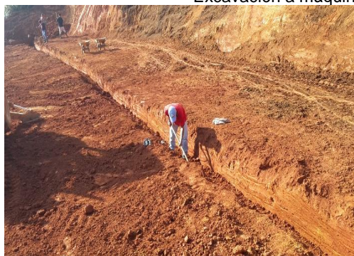
Adecuación del terreno para instalación de filtro
