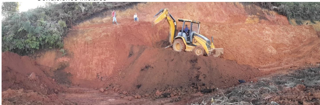
Excavación a máquina para conformación de celda
