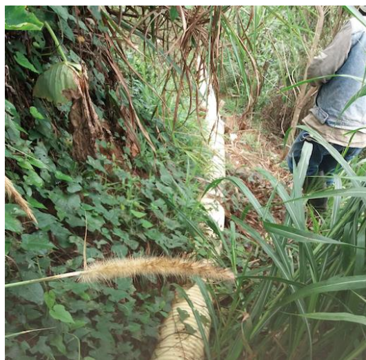
Tubería corrugada para la conducción de lixiviados
