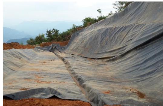
Instalación de geomembrana
