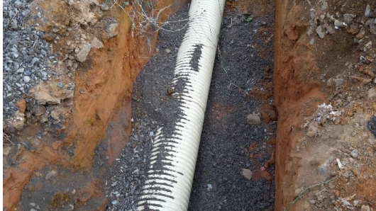
Instalación de tubería de drenaje aguas lluvias
