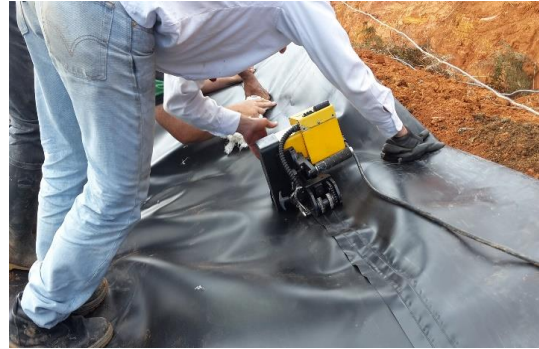
Instalación de geomembrana
