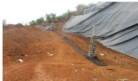
Instalación de cobertura para protección de geomembrana
