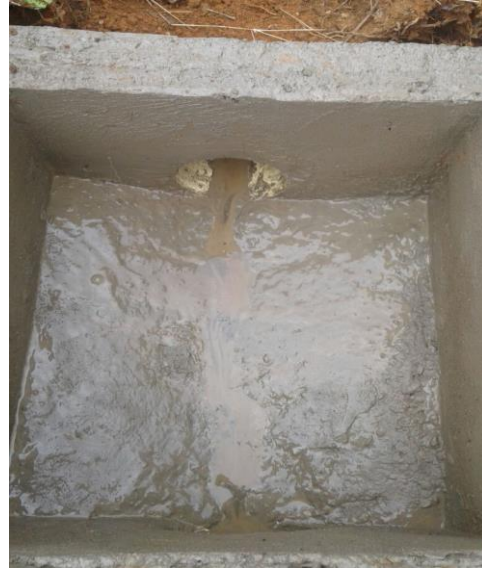
Construcción de cajas de inspección
