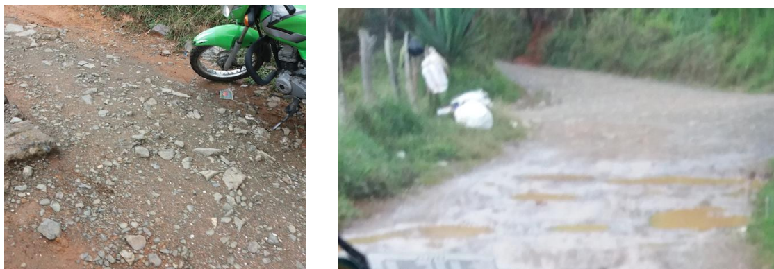
Imagen 4. Vías secundarias internas del relleno sanitario de Concordia, Antioquia
