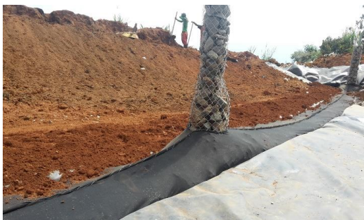
Construcción de filtros y chimeneas
