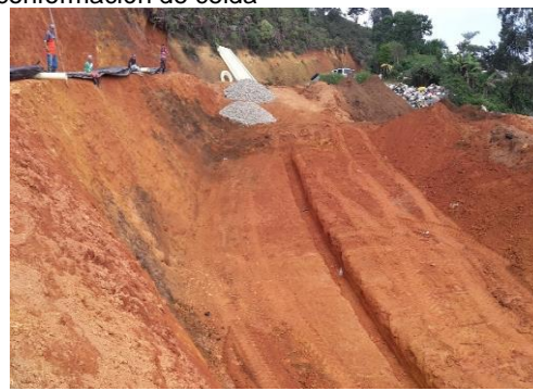
Terreno listo para instalar geomembrana
