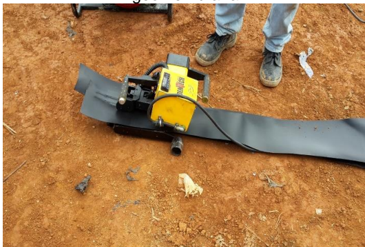
Equipo utilizado para soldadura de geomembrana
