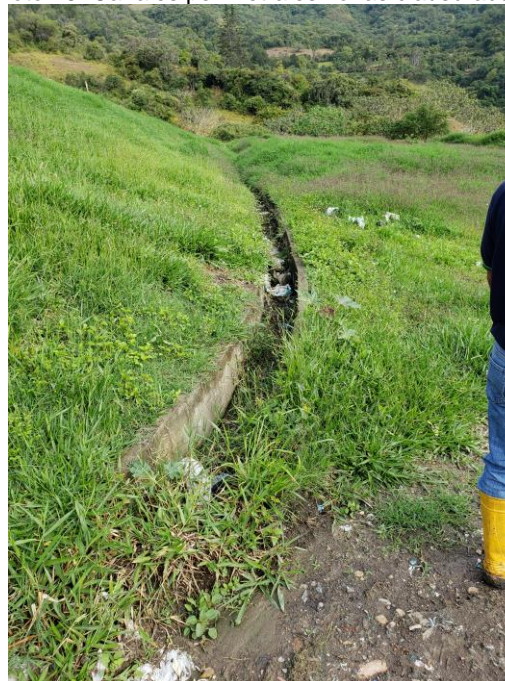
Fuente. Registro fotográfico SSPD – Visita octubre 2019
