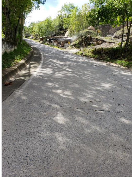
Foto 1. Vía de acceso al relleno.
