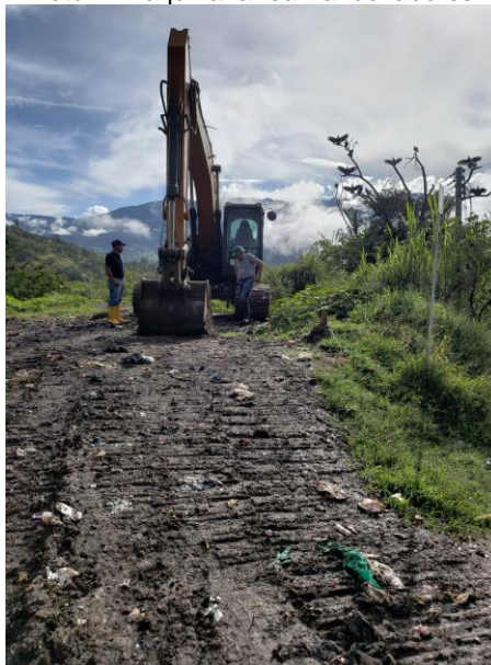
Foto 7. Maquinaria realizando labores
