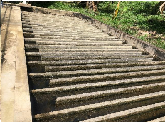
Imagen 9 y 10 Sedimentador de placas paralelas
