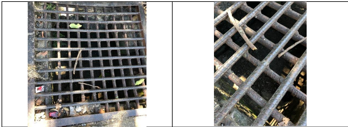
Imagen 35 y 36 sumidero Calle 2 con carrera 3
