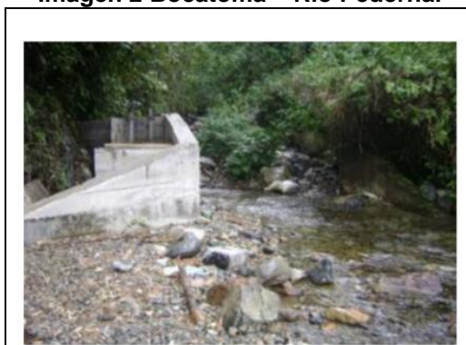
Imagen 2 Bocatoma – Río Pedernal
