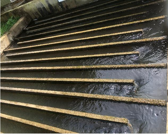
Imagen 9 y 10 Sedimentador de placas paralelas
