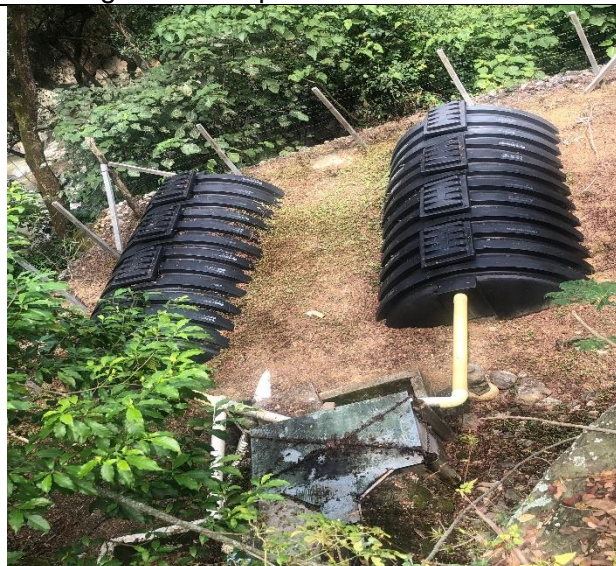
Imagen 12 Tanques de almacenamiento
