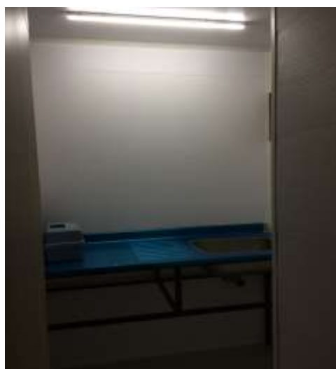
Ilustración 17 Adecuación y dotación de Laboratorio
