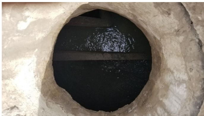
Imagen 14. Pozo de inspección Carrera 4 con calle 4.
