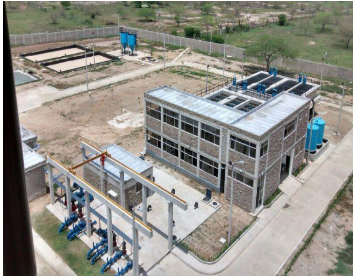
Imagen 12. PTAP, Aspecto físico planta de tratamiento
