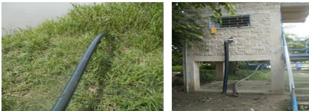
Imagen 25. Captación de Las Compuertas
