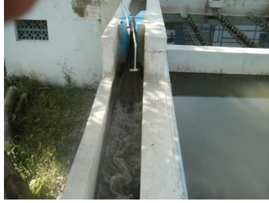
Dosificación de coagulante
