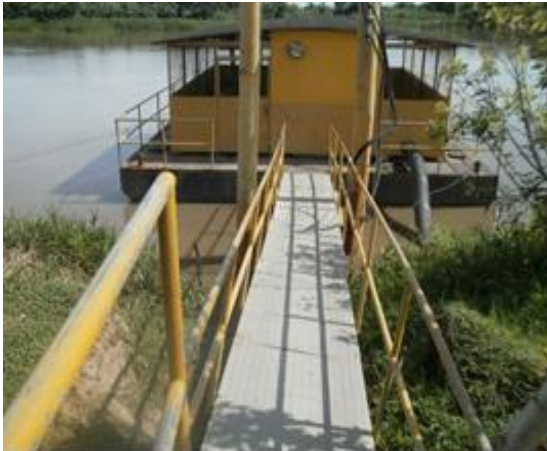
Caseta de captación
