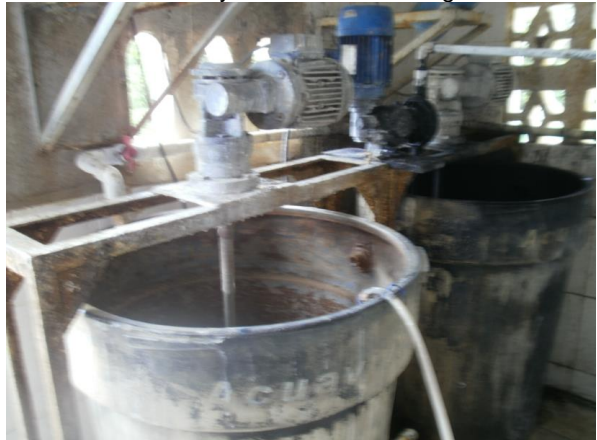
Preparación de coagulante
