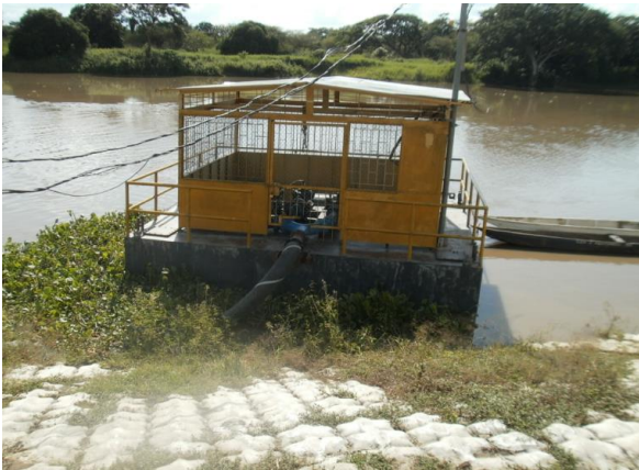
Caseta de captación
