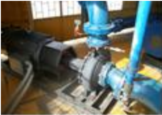
Bombas centrífugas
