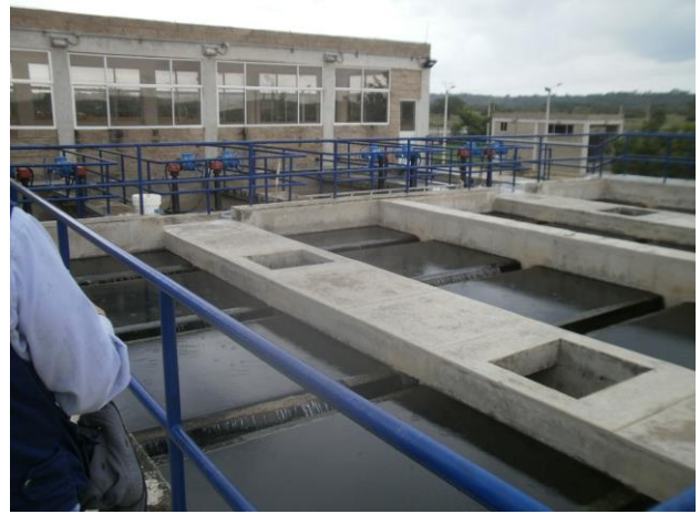
Sedimentador de alta tasa
