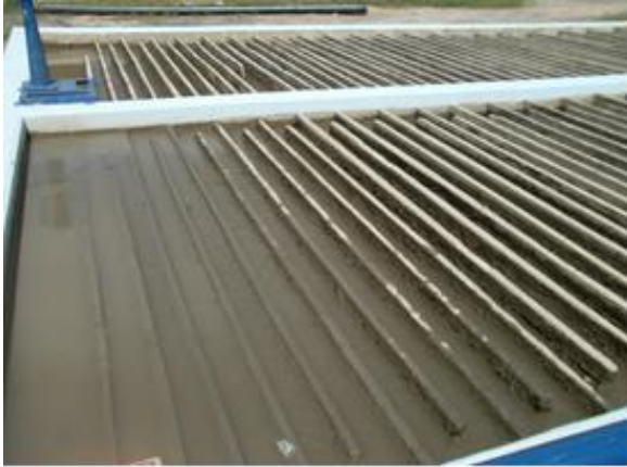
Floculación planta antigua
