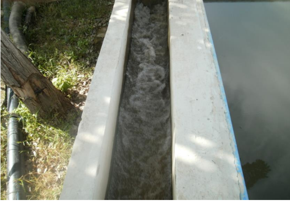
Canal de entrada
