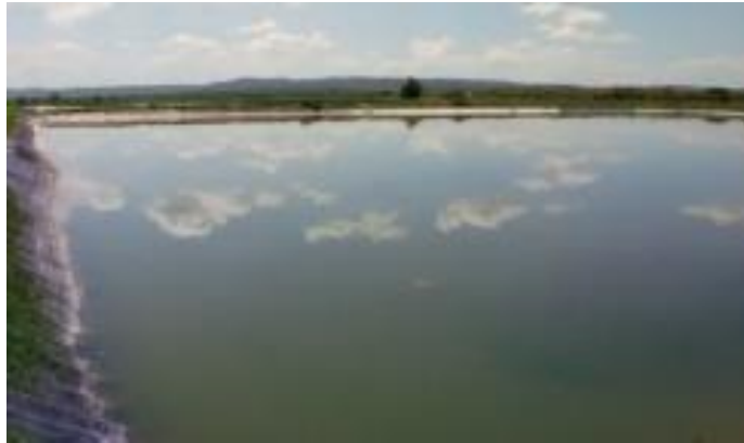
Imagen 86. Laguna de oxidación Luruaco
