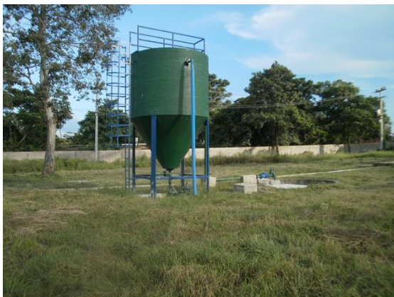
Imagen 36. Espesador de lodos
