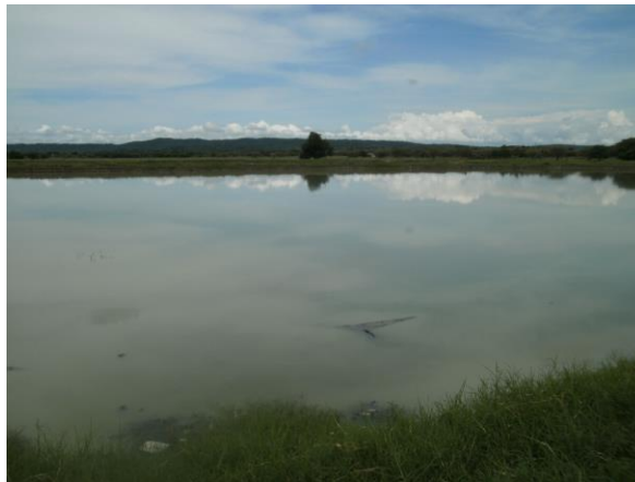
Imagen 84. Sistema lagunas de oxidación Manatí
