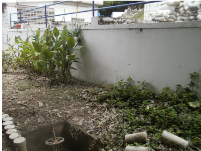
Imagen 81. Tanque de almacenamiento
