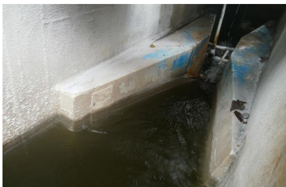
Imagen 74. Dosificación de químicos y toma de caudal de entrada
