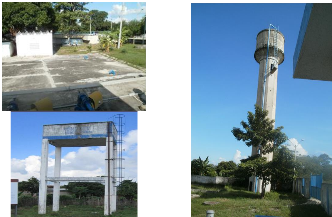
Imagen 68. Tanques de almacenamiento Santa Lucía
