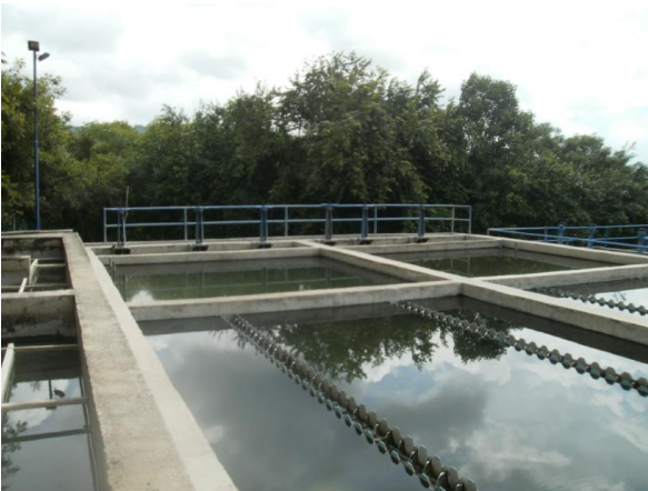
Sedimentación y Floculación
