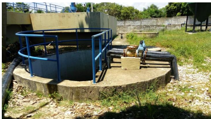
Foso de bombeo de lodos
