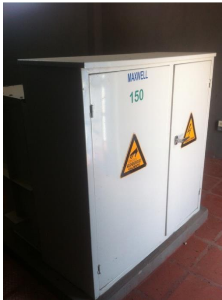
Imagen 67. Transformador 150 KVA
