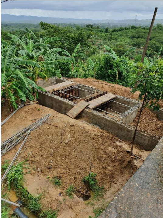
Cimentación para los nuevos filtros
