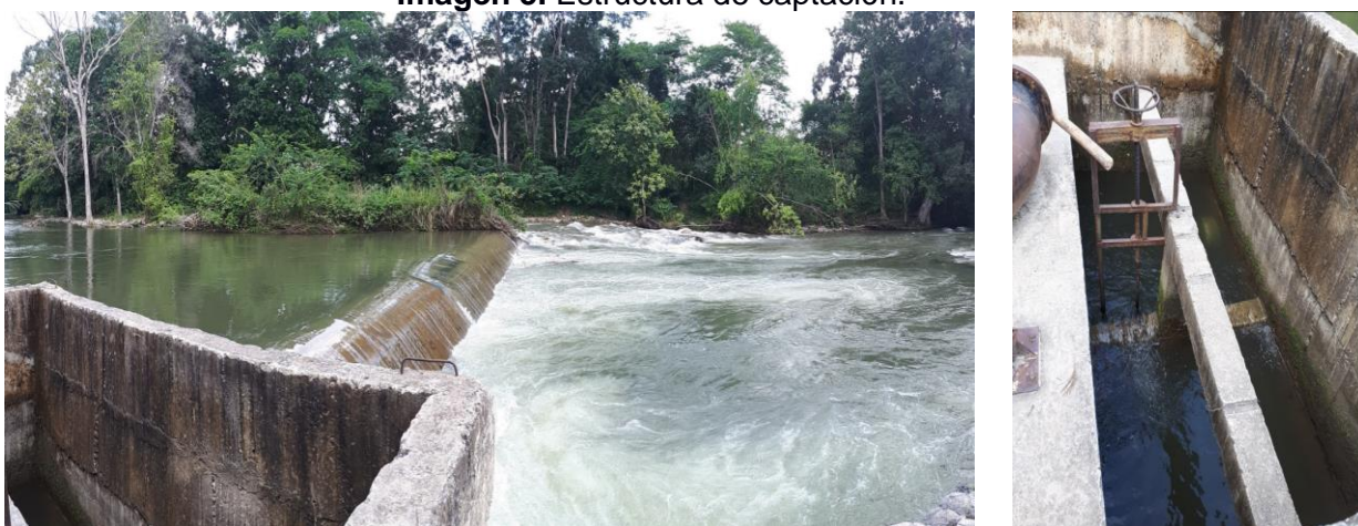
Imagen 5. Estructura de captación.
