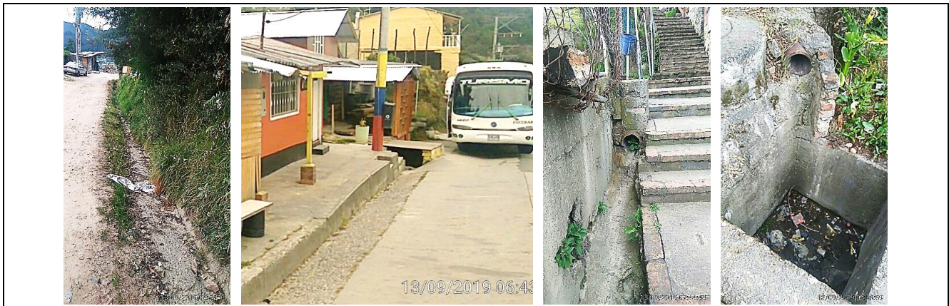
Fuente: Visita de inspección
