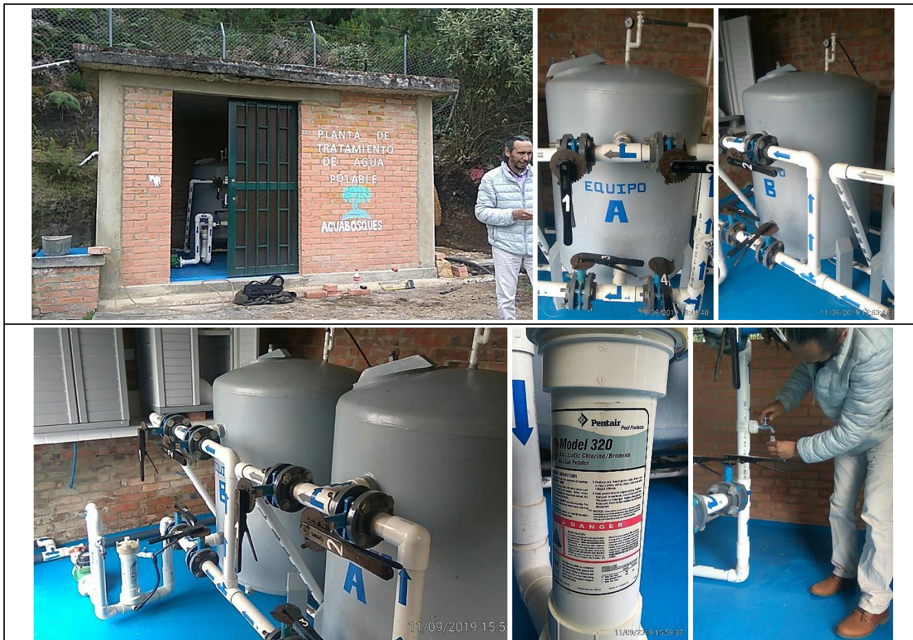
Fuente: Visita de inspección
