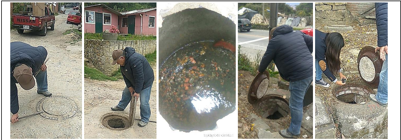
Fuente: Visita de inspección
