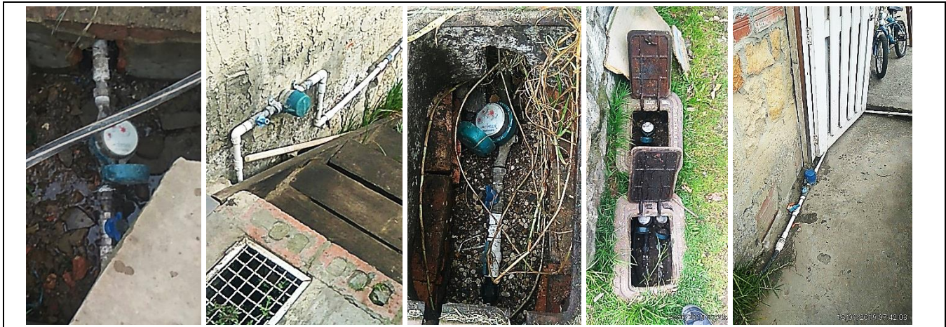
Fuente: Visita de inspección
