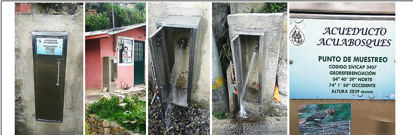
Imagen 12. Puntos concertados y materializados para la toma de muestras de calidad de agua en red de distribución del acueducto administrado por ACUABOSQUES; y acta de concertación de tales puntos.
