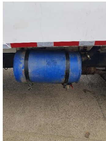
Ref. Tanque de almacenamiento de lixiviados
