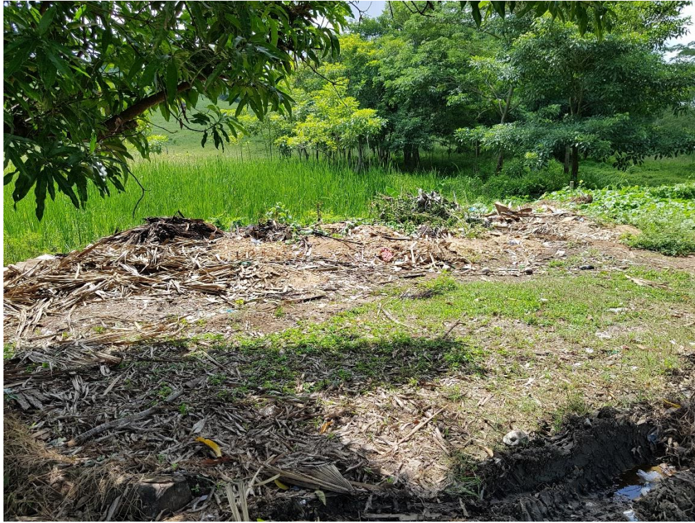
Imagen 27. Punto crítico Troncal de Occidente Sector San Isidro – Ciénaga de Oro
