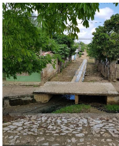
Ref. Zona de difícil acceso – Ciénaga de Oro
