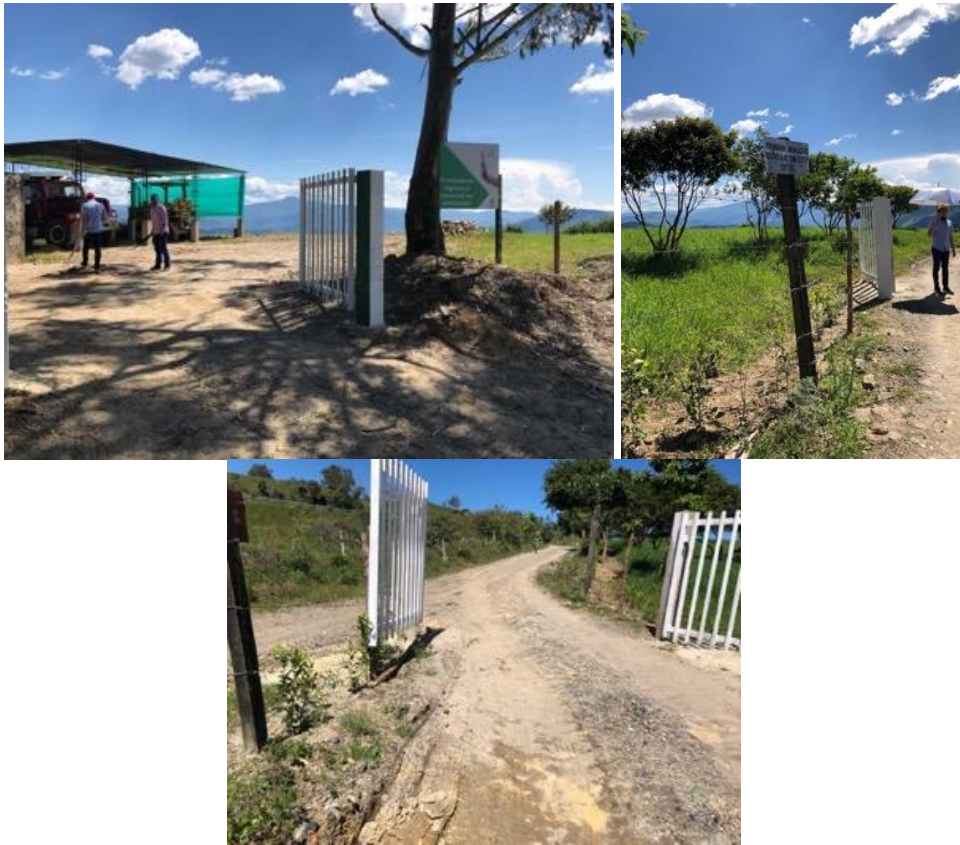
Imagen 39. Entrada al relleno y portón de ingreso
