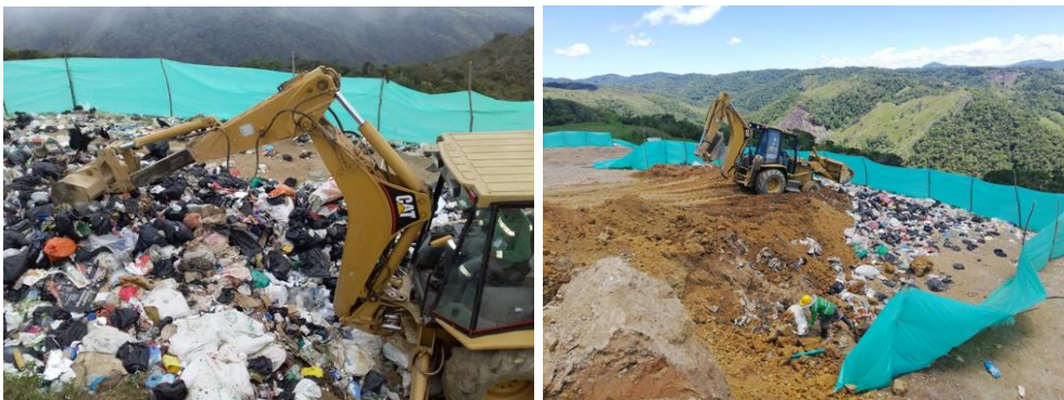
Imagen 43. La bores de cobertura en el relleno
