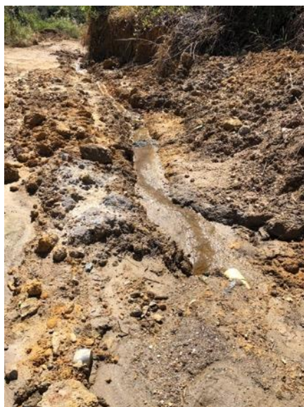
Imagen 56. Lecho de filtración y zona de vertimiento
