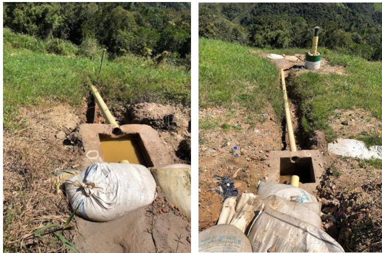
Imagen 60. Tuberías de transporte de escorrentía
