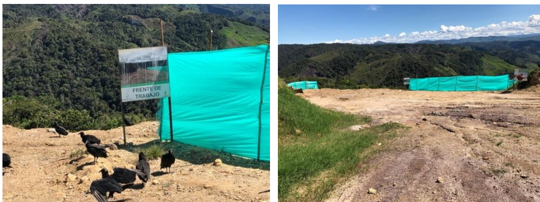
Imagen 42. Frente de trabajo del relleno sanitario
