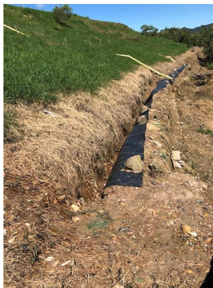
Imagen 49. Taludes para estabilidad de las celdas y captación de infiltración
