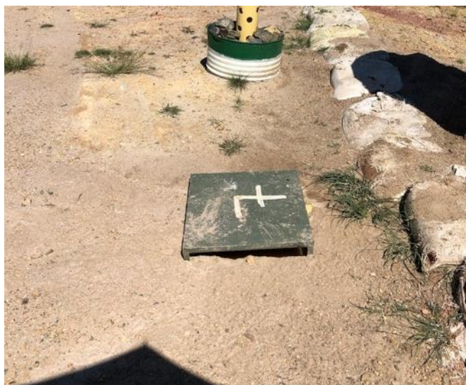
Imagen 58. Tanque de lixiviados
