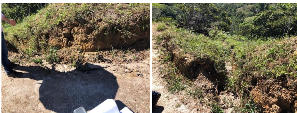
Imagen 59. Canales y cunetas perimetrales
