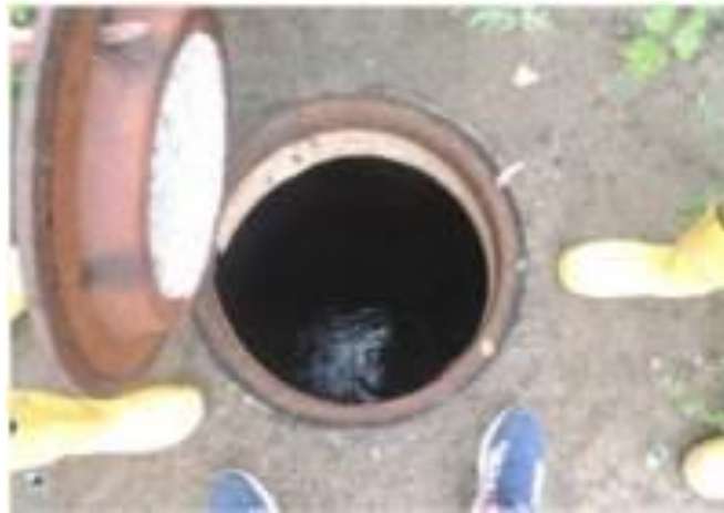
Imagen 24. Pozo de inspección
