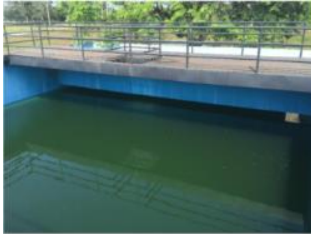
Imagen 30. Tanque de amortiguamiento
