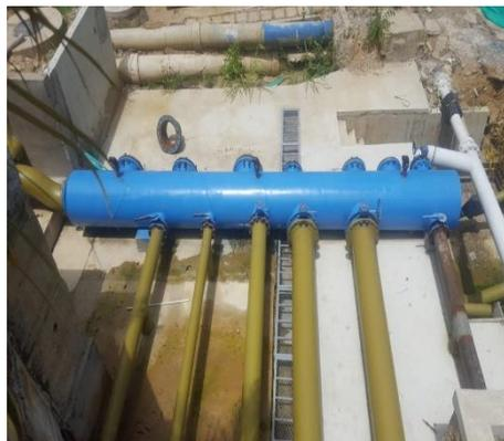
Cabezal de distribución (8 conducciones)
