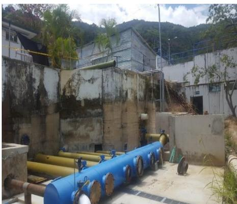
Cabezal de distribución en instalación
