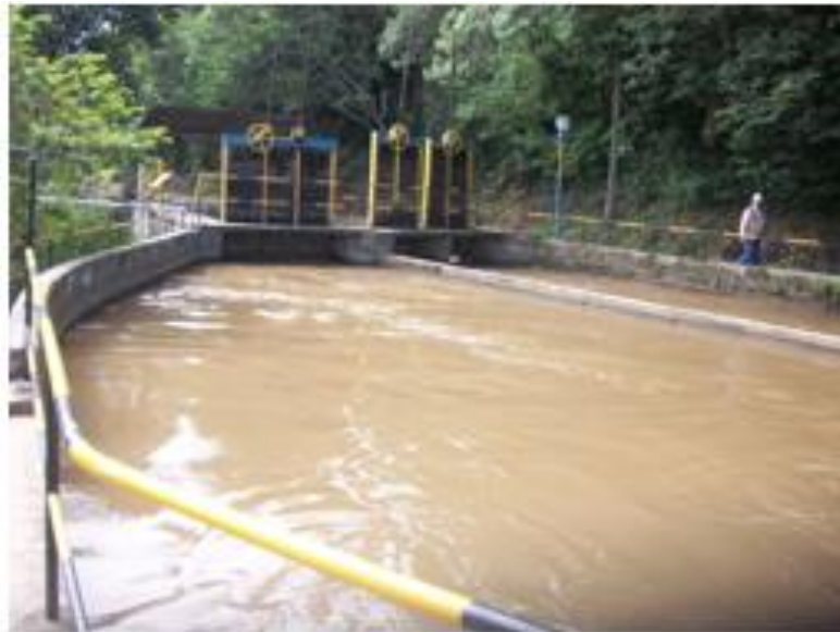
Gráfica 17. Tanque de carga La Cascada
