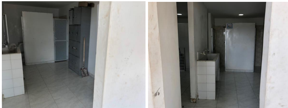
Imagen 19. Instalaciones sanitarias y vistieres
