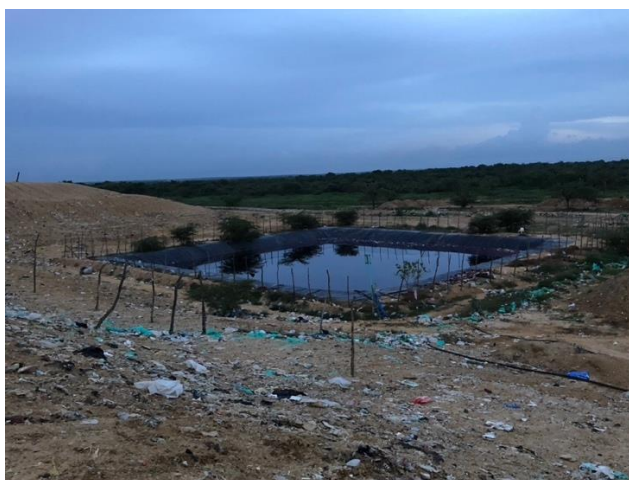
Imagen 55. Piscina de lixiviados
