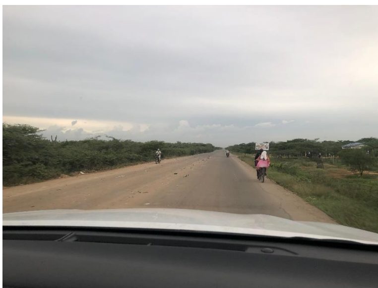
Imagen 38. Vía de acceso a la Celda Riohacha
