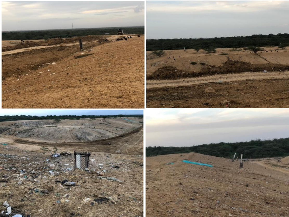
Imagen 58. Fotografías de las chimeneas instaladas en las celdas del sitio de disposición final
