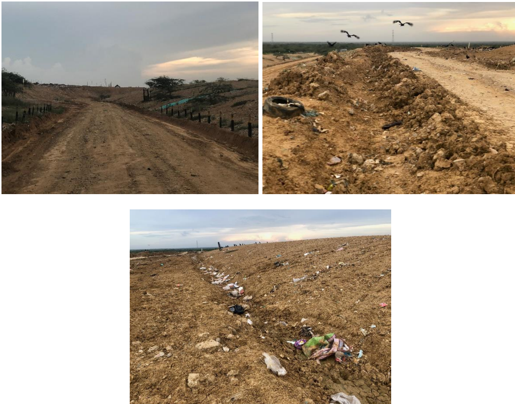
Imagen 43. Canales perimetrales en la vía interna del sitio
