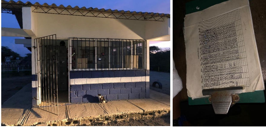
Imagen 41. Garita de seguridad y registro de ingreso de personal y/o vehículos
