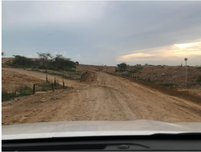
Imagen 42. Señal de giro a la derecha en la vía interna
