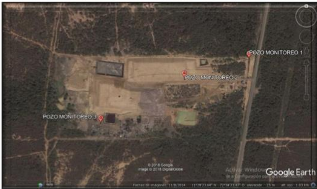
Imagen 57. Pozos de monitoreo de agua subterránea
