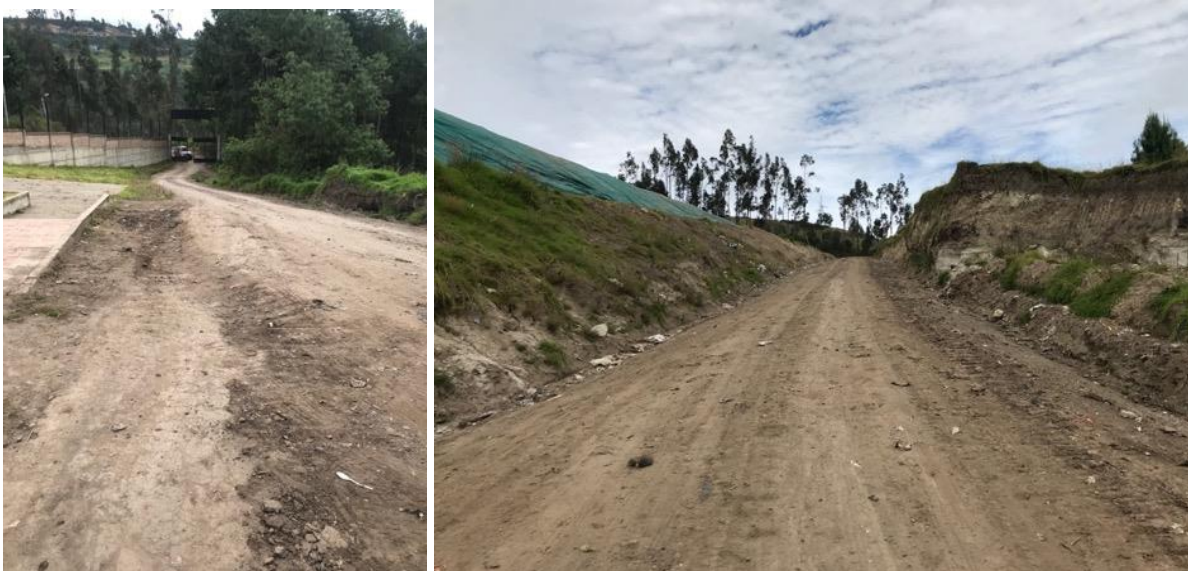
Imagen 42. Vías internas del sitio
