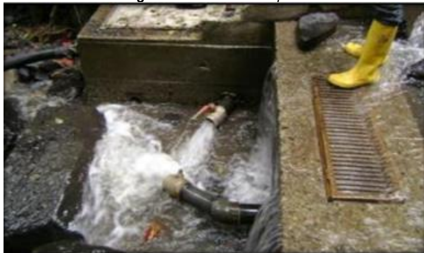
Imagen 9. Estructura de captación
