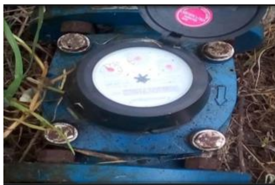
Salida de la planta
