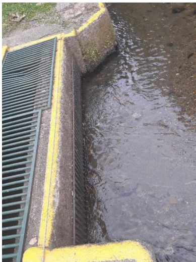
Captación superficial lateral sobre el río Molino
