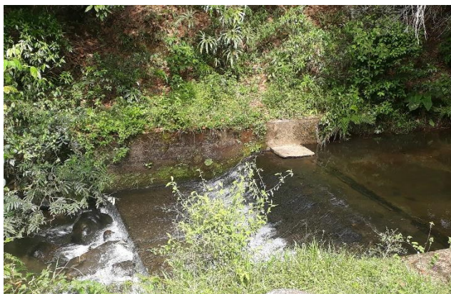
Captación superficial lateral sobre el río Pisoje
