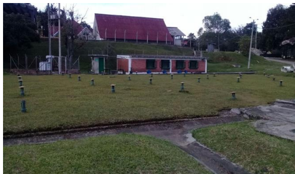
Tanque de almacenamiento para bombeo
