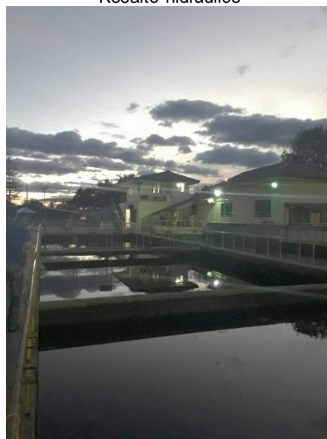
Floculación y sedimentación
