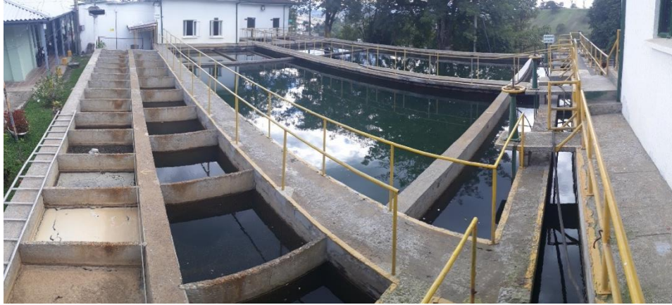
Floculación y sedimentación
