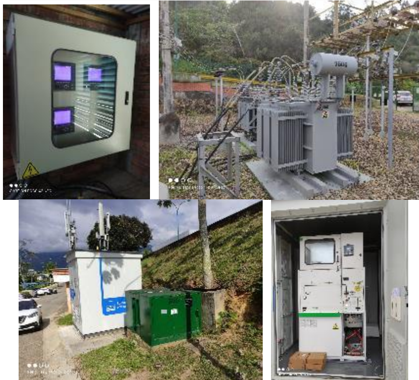
Ilustración 8. Revisión de la infraestructura del SDL de Ruitoque
