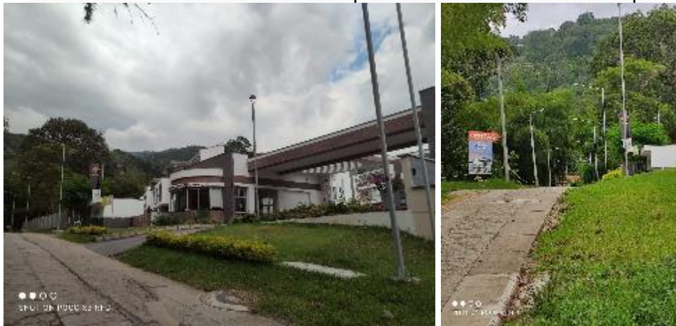
Ilustración 4. Área de cobertura del prestador – Condominio Ruitoque
