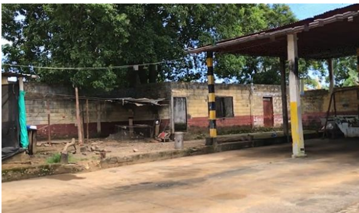
Ref. Zona de mantenimiento de vehículos
