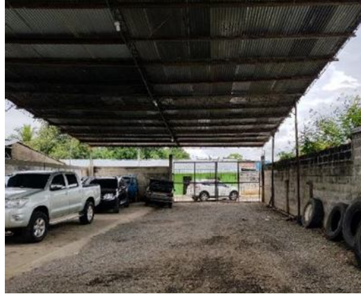
Ref. Área de parqueo de vehículos sin señalización
