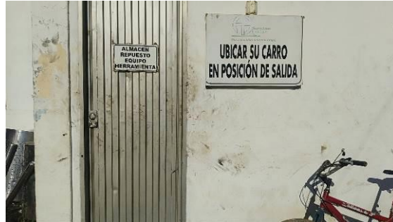
Imagen 15 Almacén de repuestos
