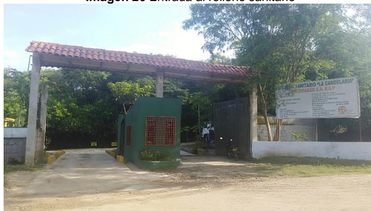
Imagen 26 Entrada al relleno sanitario
