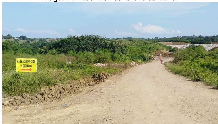
Imagen 24 Vías internas relleno sanitario
