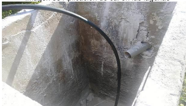
Imagen 38 Aplicación de cal en las lagunas
