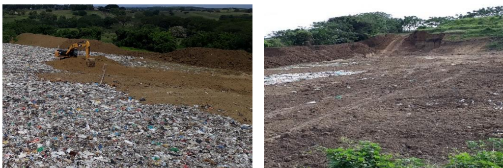
Imagen 35 Zona en proceso de cobertura
