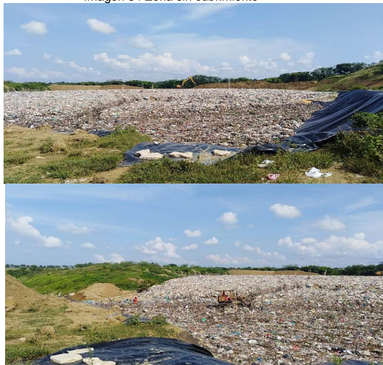
Imagen 34 Zona sin cubrimiento
