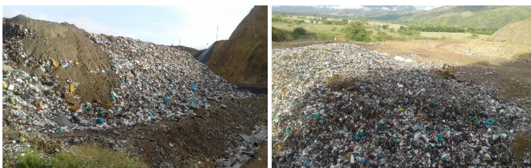
Imagen 23. Cubrimiento residuos sólidos
