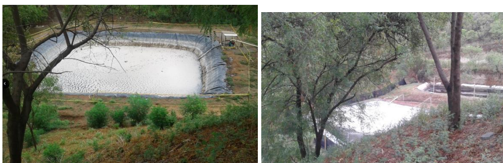
Imagen 27. Pondajes de lixiviados
