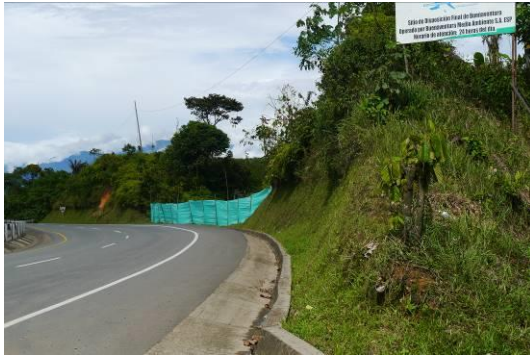
Ilustración 37. Cerramiento del predio por laderas en montaña. Fuente: Visita de inspección y vigilancia del 18 y 19 de mayo de 2017
