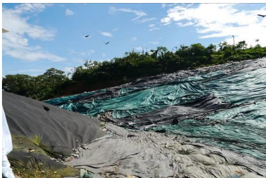
Ilustración 50. Presencia de gallinazos. Fuente: Visita de inspección y vigilancia del 18 y 19 de mayo de 2017
