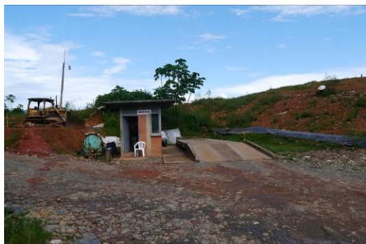
Ilustración 41. Báscula de pesaje. Fuente: Visita de inspección y vigilancia del 18 y 19 de mayo de 2017
