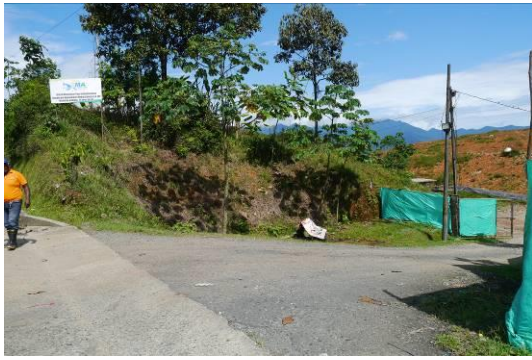
Ilustración 33. Vía de ingreso a la Celda Transitoria. Fuente: Visita de inspección y vigilancia del 18 y 19 de mayo de 2017
