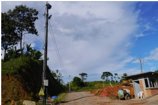
Ilustración 35. Vía de paso a la báscula. Fuente: Visita de inspección y vigilancia del 18 y 19 de mayo de 2017
