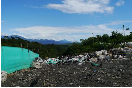
Ilustración 45. Presencia recicladores en el frente de trabajo. Fuente: Visita de inspección y vigilancia del 18 y 19 de mayo de 2017
