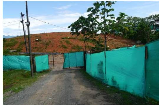
Ilustración 40. Portón de Ingreso a la Celda Transitoria. Fuente: Visita de inspección y vigilancia del 18 y 19 de mayo de 2017
