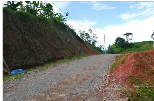
Ilustración 36. Vía interna al frente de trabajo. Fuente: Visita de inspección y vigilancia del 18 y 19 de mayo de 2017
