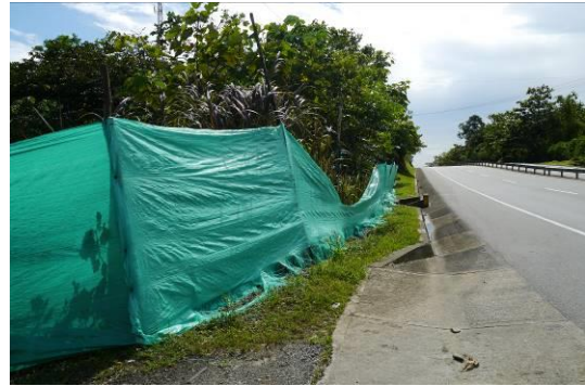
Ilustración 38. Cerramiento con lona verde. Fuente: Visita de inspección y vigilancia del 18 y 19 de mayo de 2017
