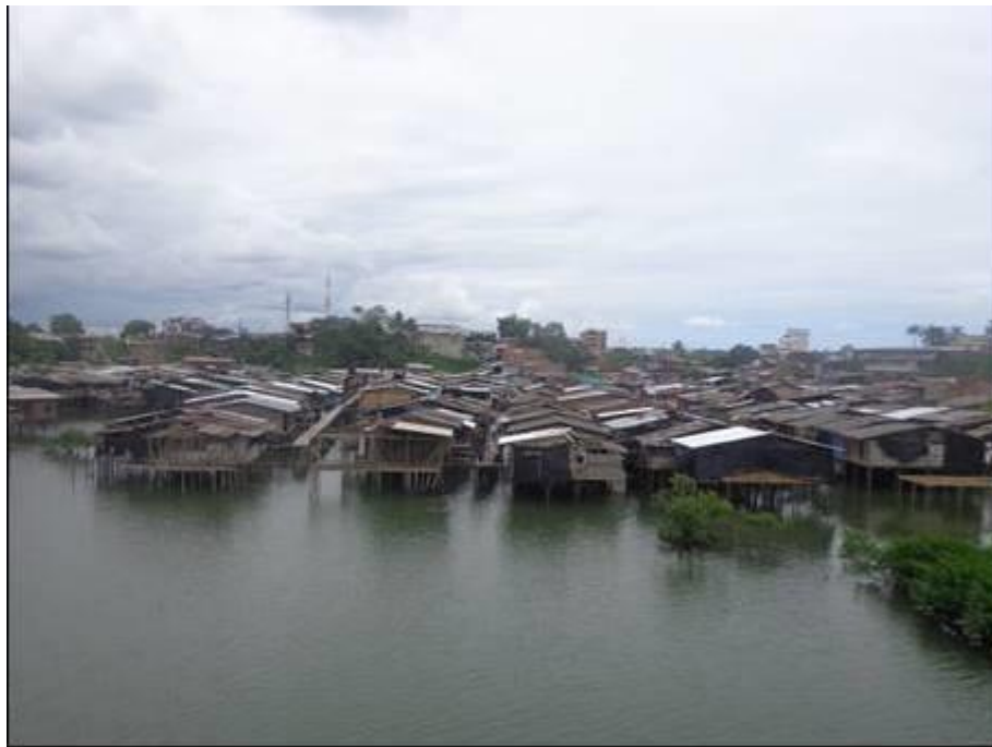
Ilustración 6. Zona de palafitos. Fuente: Visita de inspección y vigilancia del 18 y 19 de mayo de 2017
