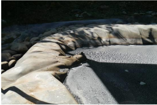
Ilustración 56. Recepción de lixiviado para vertimiento. Fuente: Visita de inspección y vigilancia del 18 y 19 de mayo de 2017
