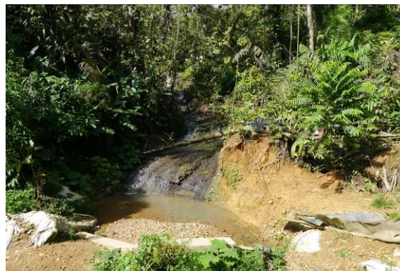
Ilustración 47. Quebrada encausada y conducida bajo la celda
