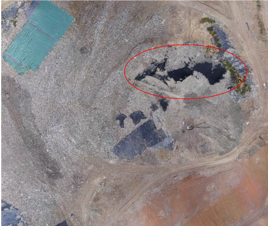
Ilustración 55. Afloramiento de lixiviados en terrazas 1A y 1B de la Zona de Optimización Fase 2. Afloramiento de lixiviados encerrados en rojo. Fuente: Advector
