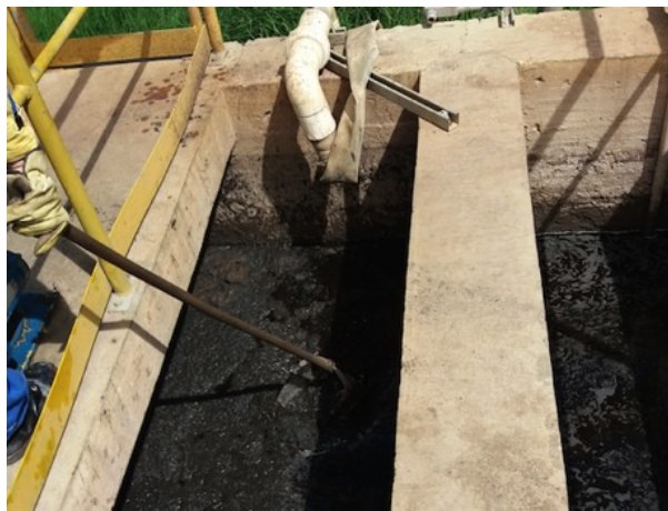
Ilustración 64. Remoción manual del sobrenadante en el proceso de coagulación/floculación. Fuente: Visita de inspección y vigilancia del 30 de junio de 2017.
