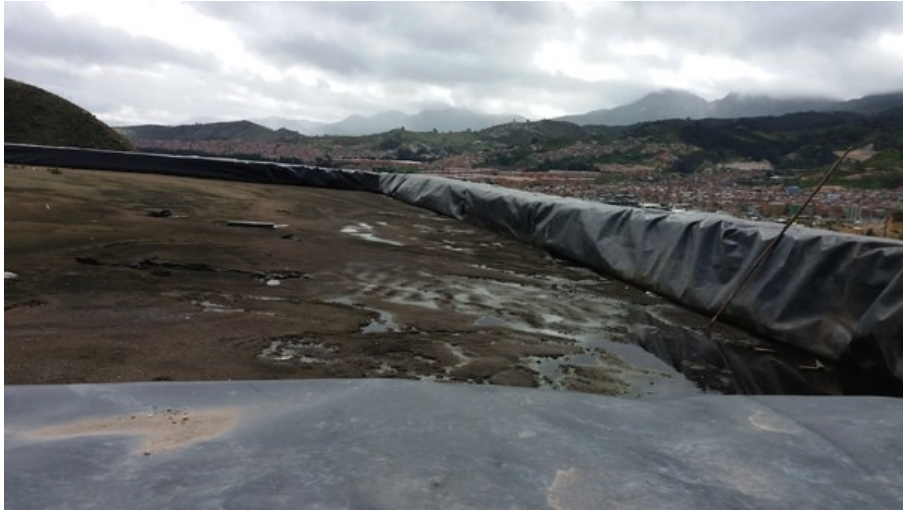
Ilustración 81. Almacenamiento de lodos. Fuente: Visita de inspección y vigilancia del 30 de junio de 2017
