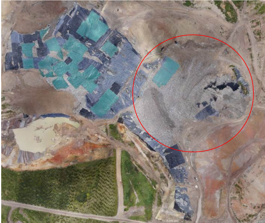
Ilustración 54. Sección del mosaico zonas sin cobertura en Zona de Optimización Fase 2. Zona del deslizamiento encerrada en rojo. Fuente: Advector
