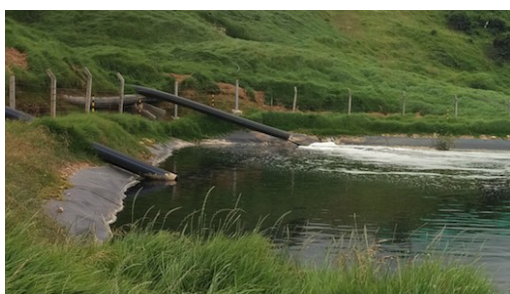
Ilustración 76. Pondaje 7 con capacidad 3700 m 3 . Fuente: Visita de inspección y vigilancia del 30 de junio de 2017
