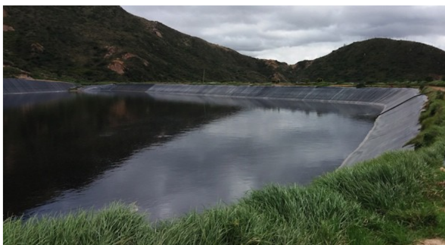
Ilustración 78. Celda 6 con un volumen de lixiviados almacenados de 22380 m 3 . Fuente: Visita de inspección y vigilancia del 30 de junio de 2017
