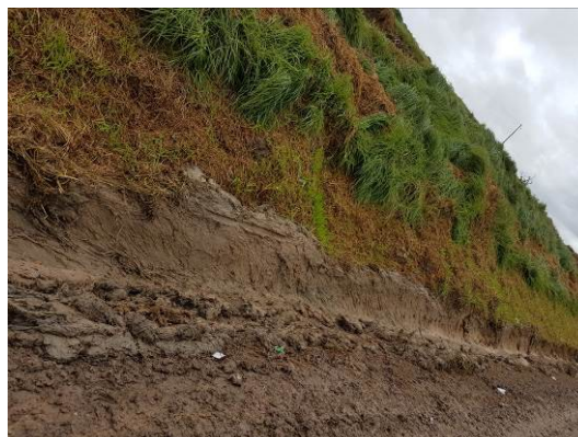
Ilustración 59. Canal para el control de escorrentía, tramo sobre el terreno natural. Fuente: Visita de inspección y vigilancia del 06 de julio de 2017
