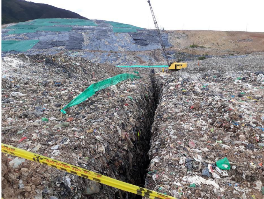
Ilustración 49. Labores de perforación profunda en zona afectada por el deslizamiento del 02 de octubre de 2015. Fuente: Visita de inspección y vigilancia del 18 de agosto de 2017.
