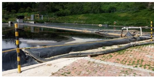
Ilustración 75. Pondajes de la planta de tratamiento de lixiviados. Capacidad total 1998 m 3 . Fuente: Visita de inspección y vigilancia del 30 de junio de 2017
