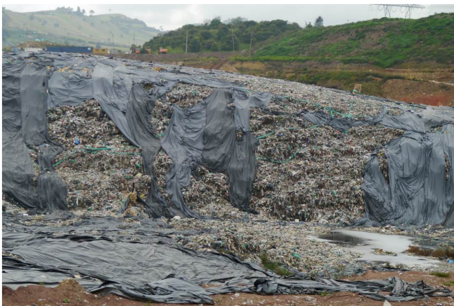
Ilustración 46. Áreas sin cobertura en zona del deslizamiento. Fuente: Visita de inspección y vigilancia del 08 de mayo de 2017
