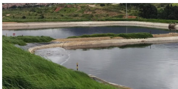
Ilustración 77. Pondaje 2 conformado por 4 piscinas con una capacidad total de 33441 m 3 . Fuente: Visita de inspección y vigilancia del 30 de junio de 2017
