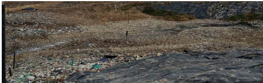
Ilustración 50. Afloramiento de lixiviados en zona afectada por el deslizamiento del 02 de octubre de 2015. Fuente: Visita de inspección y vigilancia del 18 de agosto de 2017.
