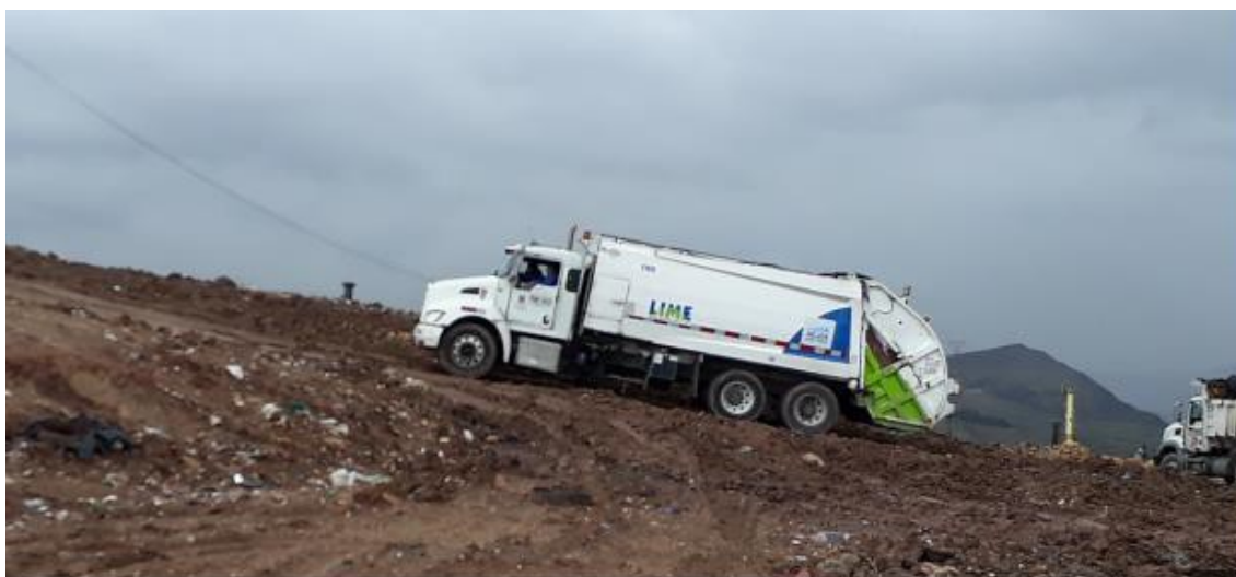
Ilustración 10. Pendiente vía de acceso al frente de trabajo, sector "La Rampa". Fuente: Visita de inspección y vigilancia del 08 de marzo de 2017
