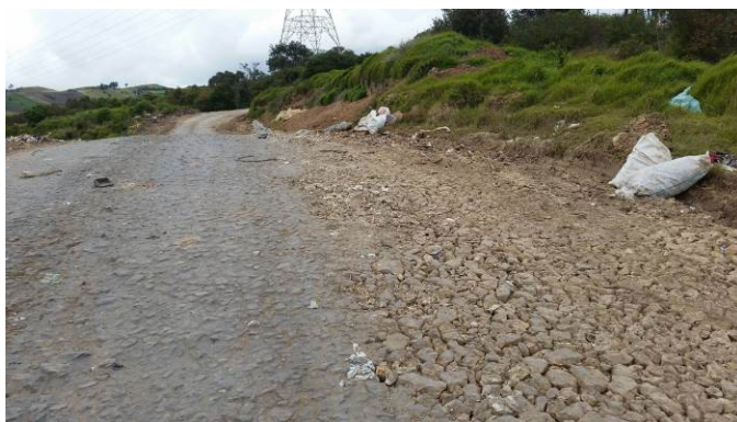
Ilustración 14. Intervención de vía paralela al canal Puente Tierra. Fuente: Visita de inspección y vigilancia del 11 de agosto de 2017
