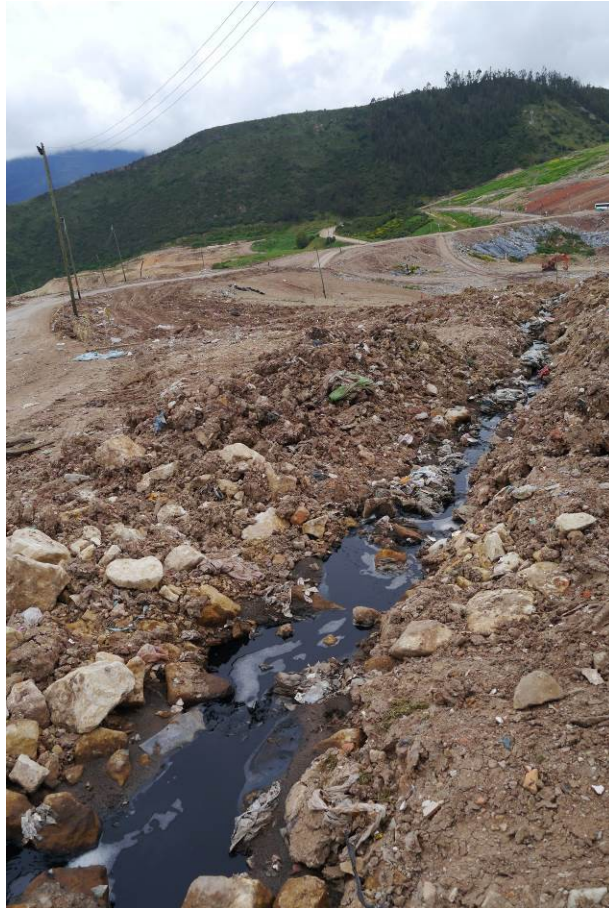
Ilustración 47. Cauce de lixiviados sobre zona del deslizamiento. Fuente: Visita de inspección y vigilancia del 08 de mayo de 2017
