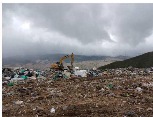
Ilustración 30. Retroexcavadora en frente de trabajo Zona Biosólidos. Fuente: Visita de inspección y vigilancia del 06 de julio de 2017
