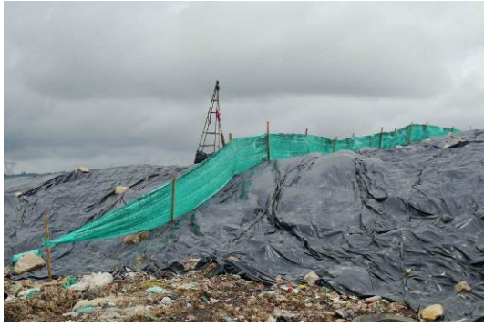
Ilustración 32. Trampa adhesiva en el frente operativo. Fuente: Visita de inspección y vigilancia del 08 de mayo de 2017
