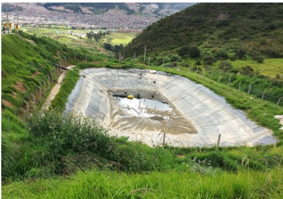
Ilustración 82. Secador de lodos. Fuente: Visita de inspección y vigilancia del 30 de junio de 2017
