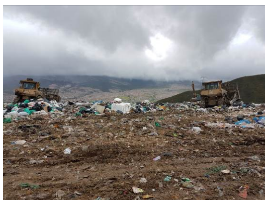
Ilustración 29. Buldóceres en frente de trabajo Zona Biosólidos. Fuente: Visita de inspección y vigilancia del 06 de julio de 2017
