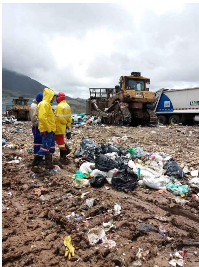
Ilustración 31. Buldóceres en frente de trabajo Zona VII Área 2. Fuente: Visita de inspección y vigilancia del 09 de agosto de 2017
