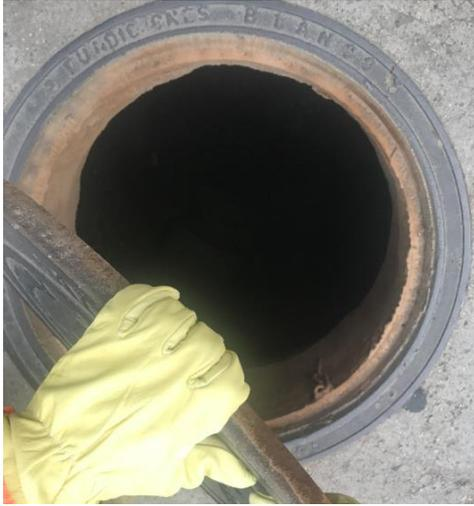
Colector ubicado en la calle 5b carrera 4: flujo normal, tapa en buen estado.
