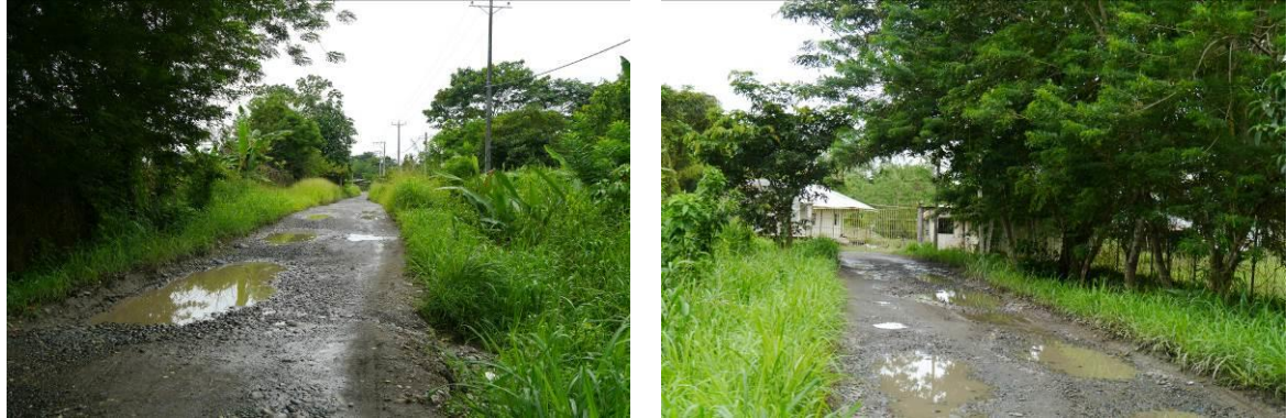
Imagen 21. Estado de la vía externa de acceso al Relleno Sanitario Buchelly
