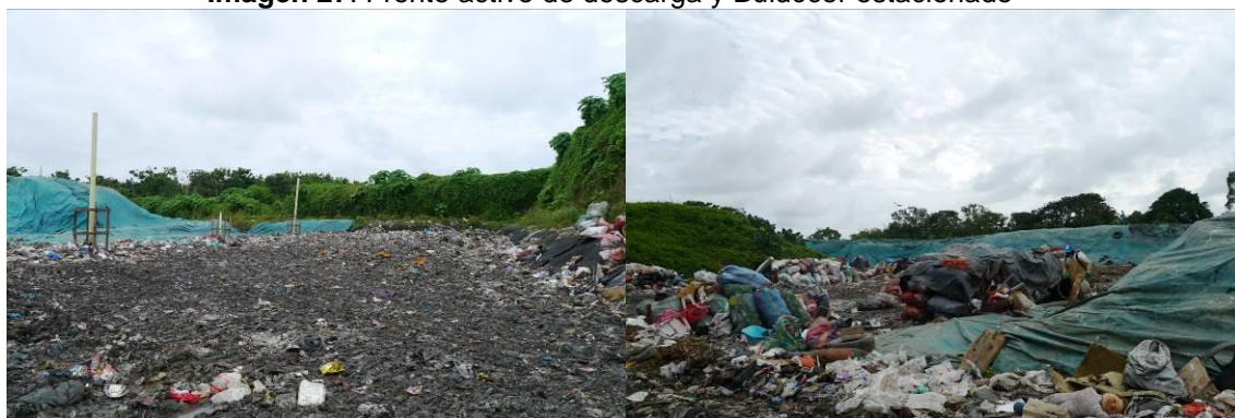
Imagen 27. Frente activo de descarga y Buldócer estacionado
