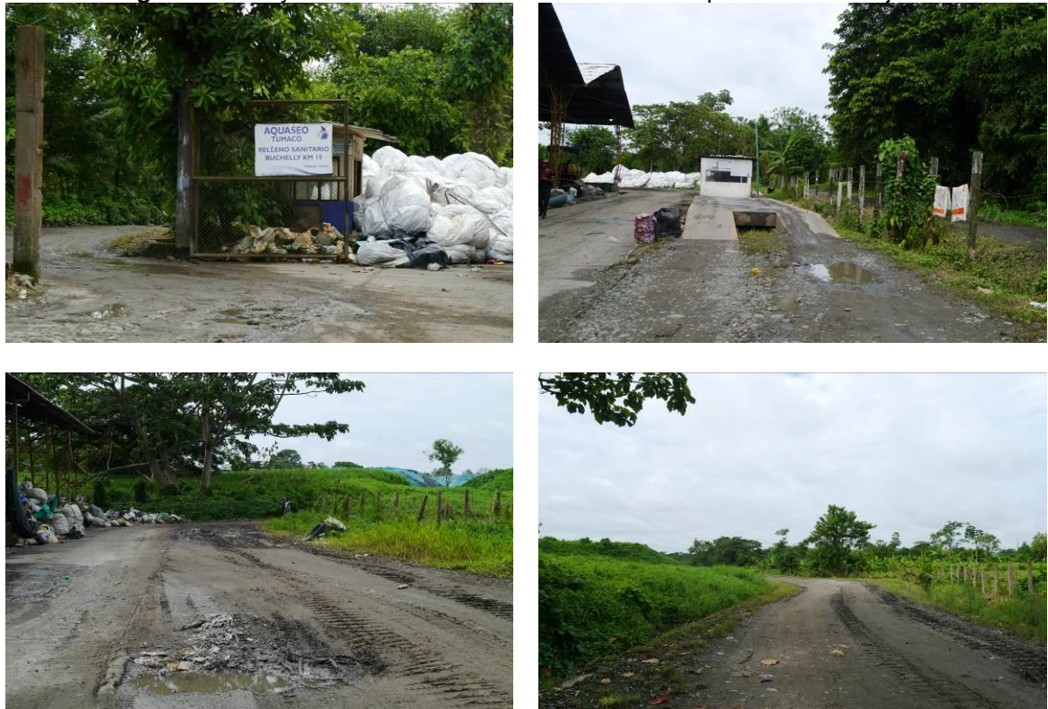
Imagen 22. Vías y caminos internos de acceso al frente operativo de trabajo
