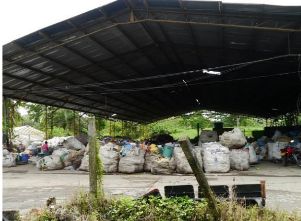
Imagen 24. Recicladores en el relleno sanitario Buchelly
