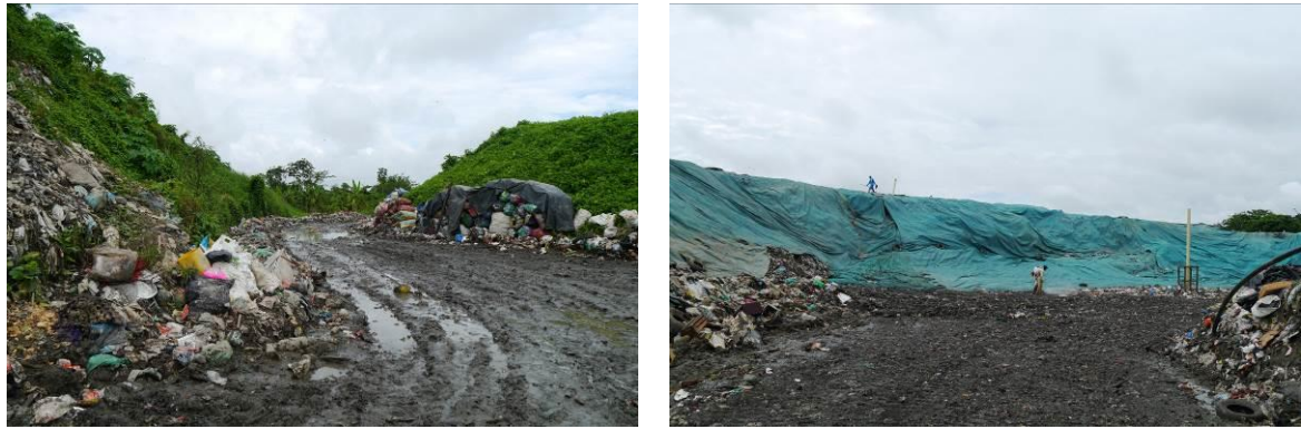
Fuente: Registro Fotográfico en el momento de la visita
