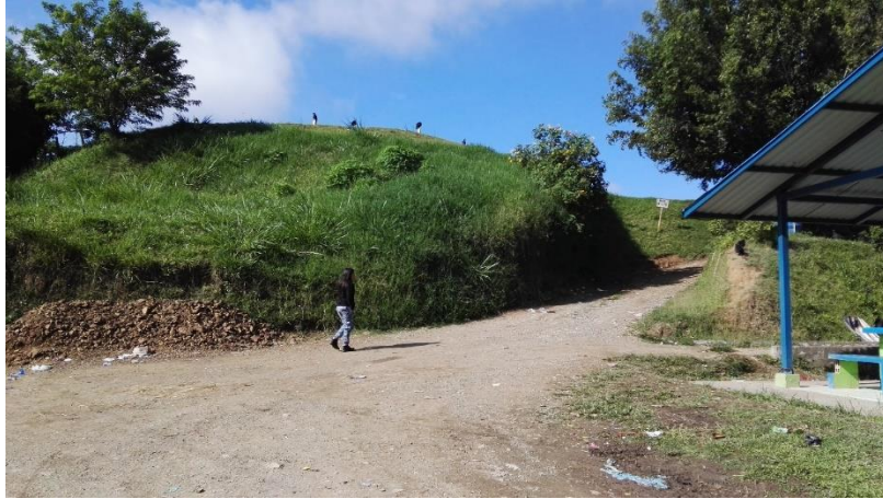
Imagen 20. Vía interna con acceso al frente de trabajo
