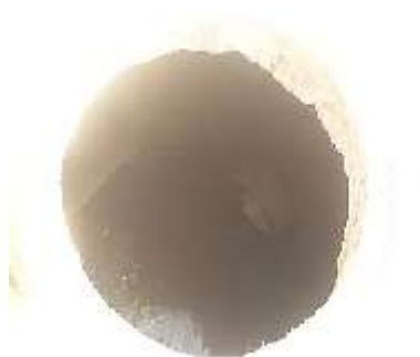
Imagen 30 Pozo de inspección
