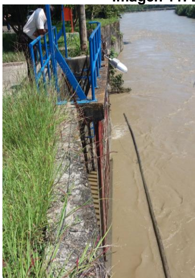
a) Estructura de captación.
