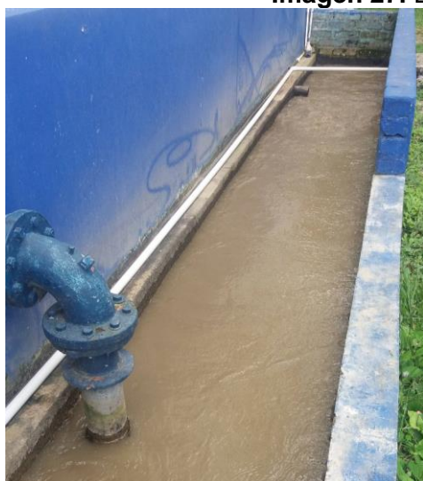
a) Canal de entrada a la PTAP.
