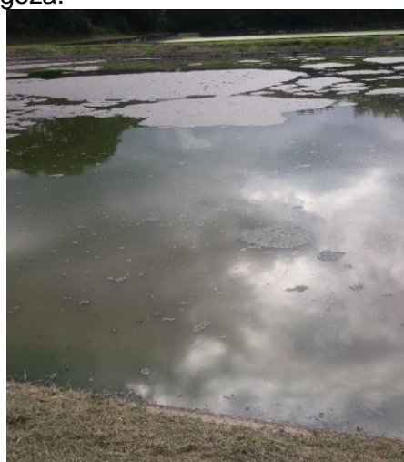
b) Laguna de oxidación
