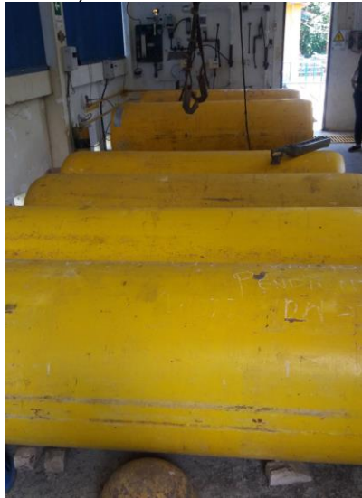
e) Tanques de cloro gaseoso.
