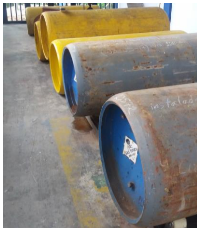
e) Tanques de cloro gaseoso.
