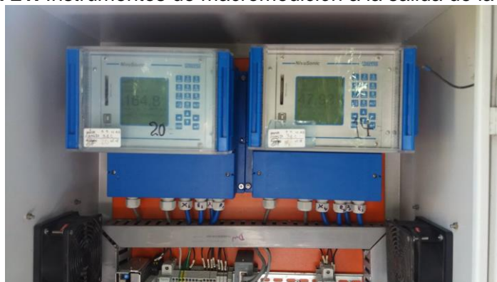
Imagen 21. Instrumentos de macromedición a la salida de la PTAP 1.
