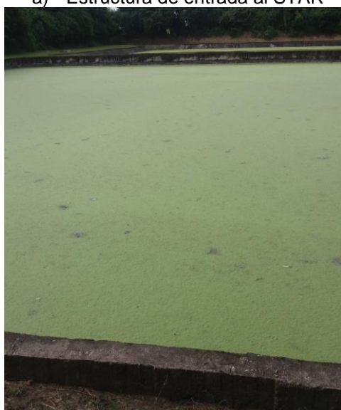
c) Presencia de cobertura vegetal en las lagunas de oxidación.
