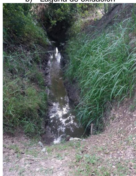
d) Descarga a la quebrada El Salto.
