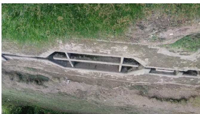
a) Estructura de entrada al STAR
