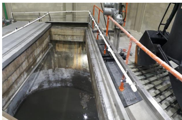
Pozo de ingreso
