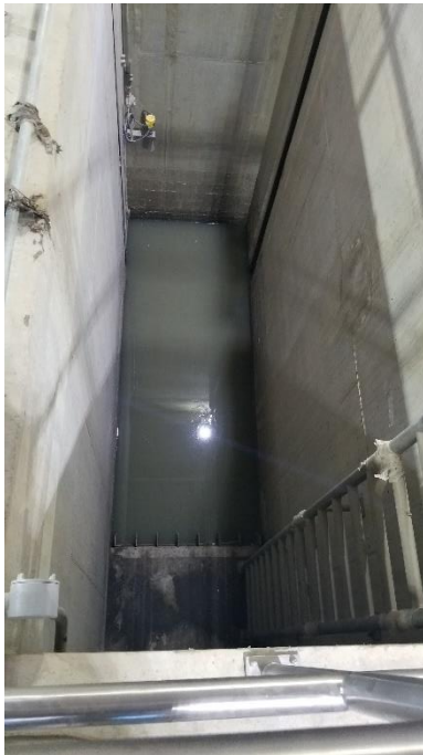
Reja principal a la entrada de la PTAR
