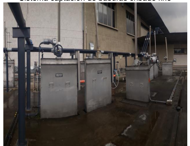
Desarenadores cubiertos
