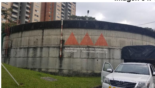
Tanque Las Brujas
