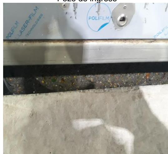
Cribado Fino (Placas Perforadas)
