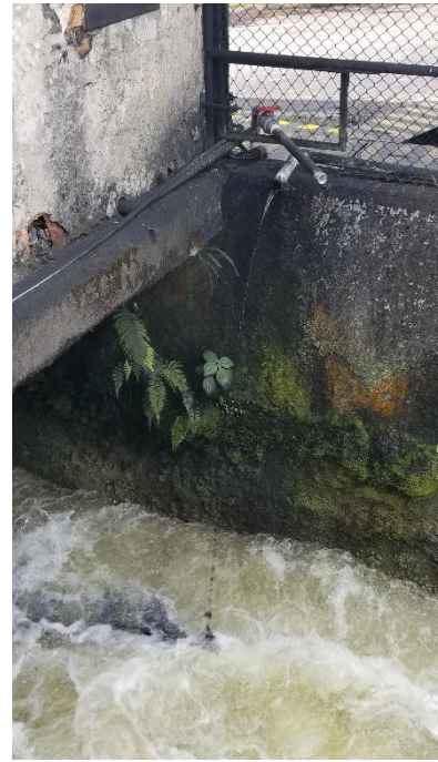
Punto de aplicación de carbón activado
