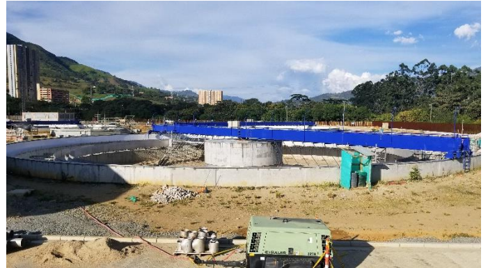
Sedimentador secundario
