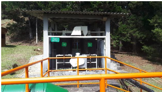
Preparación y aplicación de carbón activado
