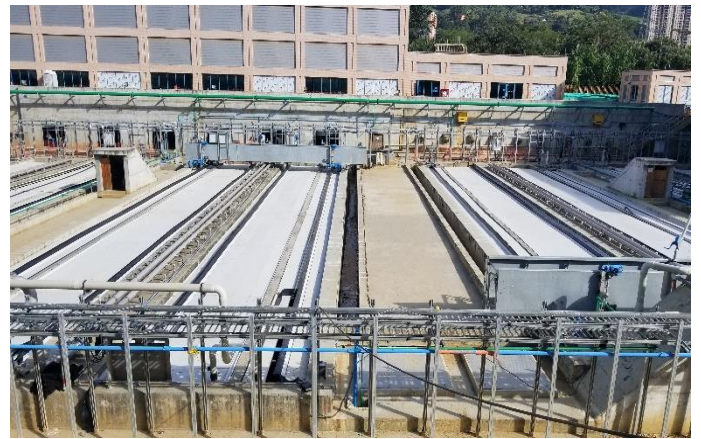
Desarenador (En pruebas)
