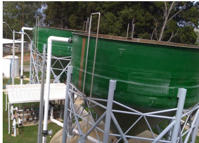
Tanques de pre espesado
