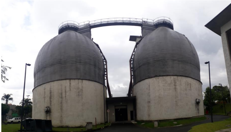
digestores anaeróbicos
