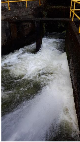
Estructura de disipación de energía
