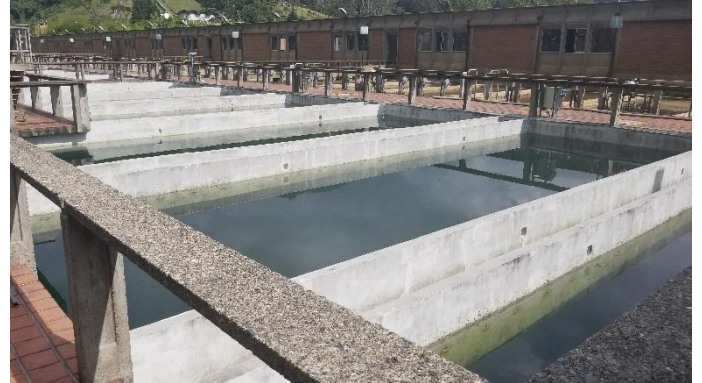
Unidades de floculación / sedimentación
