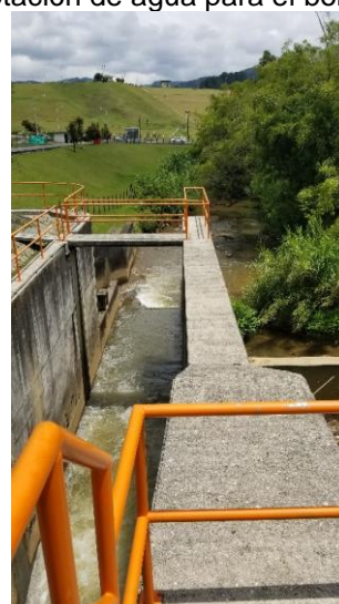
Río Pantanillo (Aguas abajo del bombeo)
