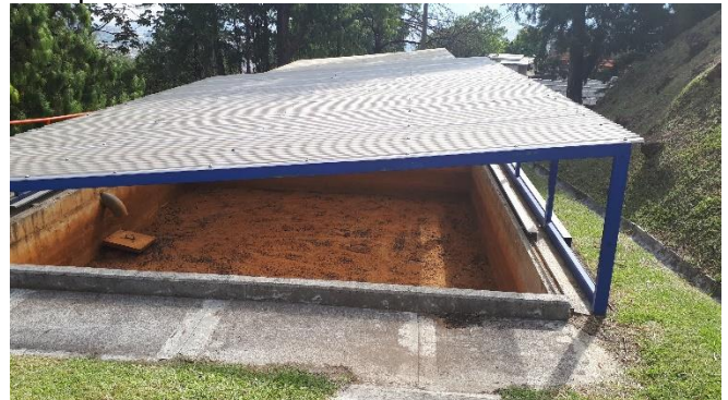
Secado de lodos
