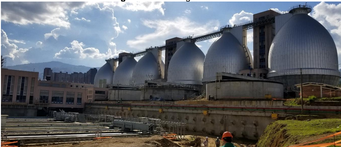
Imagen 44. PTAR Aguas Claras.
