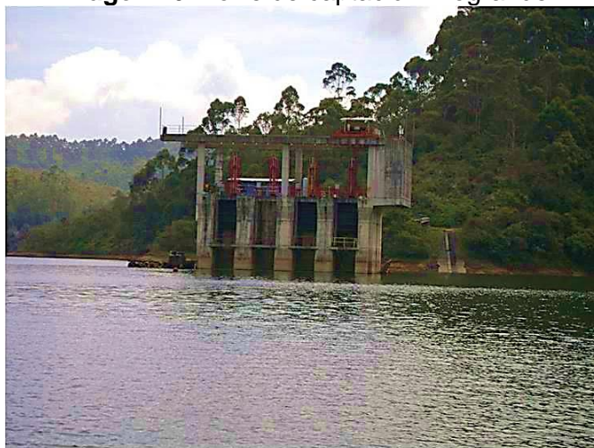
Imagen 16. Torre de captación Riogrande
