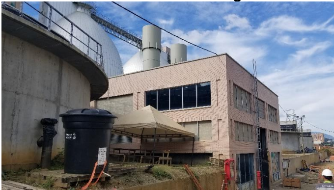
Edificio de control de olores
