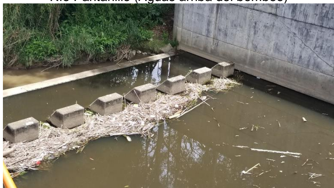
Estructura de disipación de energía
