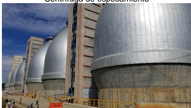
Digestores anaeróbicos
