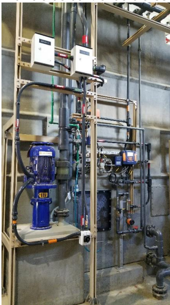
Tratamiento del aire
