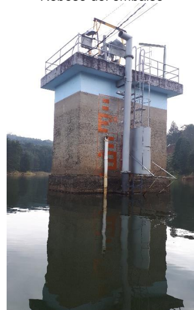
Torre de captación
