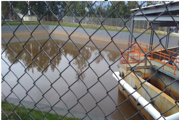
Laguna de homogenización
