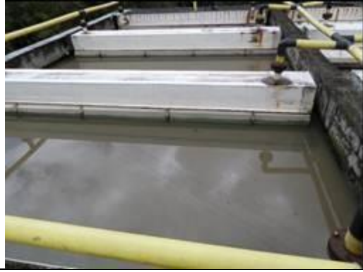
Foto 33. Mitad de la estructura del reactor que se encontraba operando
