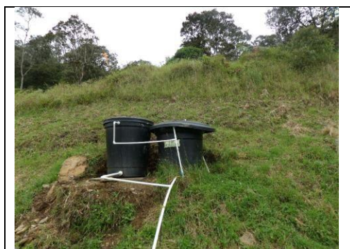
Foto 17. Registro fotográfico de tanque de almacenamiento
