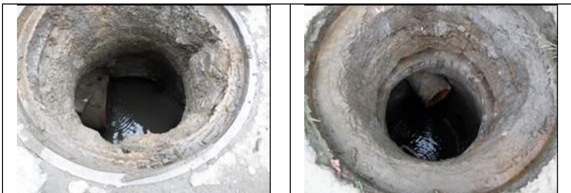
Fotos 22 y 23. Pozos de inspección en buen estado de mantenimiento
