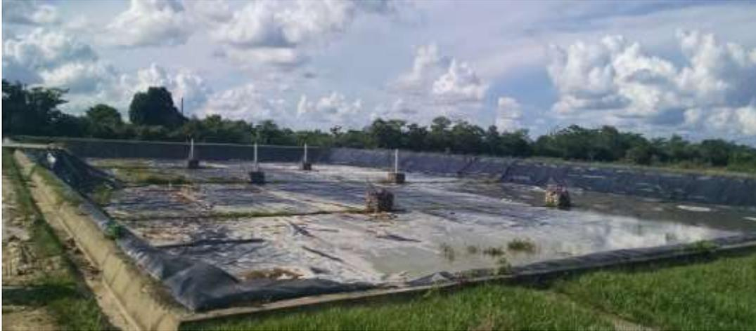
Foto 24 Canal de aguas lluvias y Chimeneas para evacuación de gases
