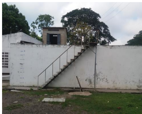
Figura 17. Tanque de almacenamiento Re-bombeo
