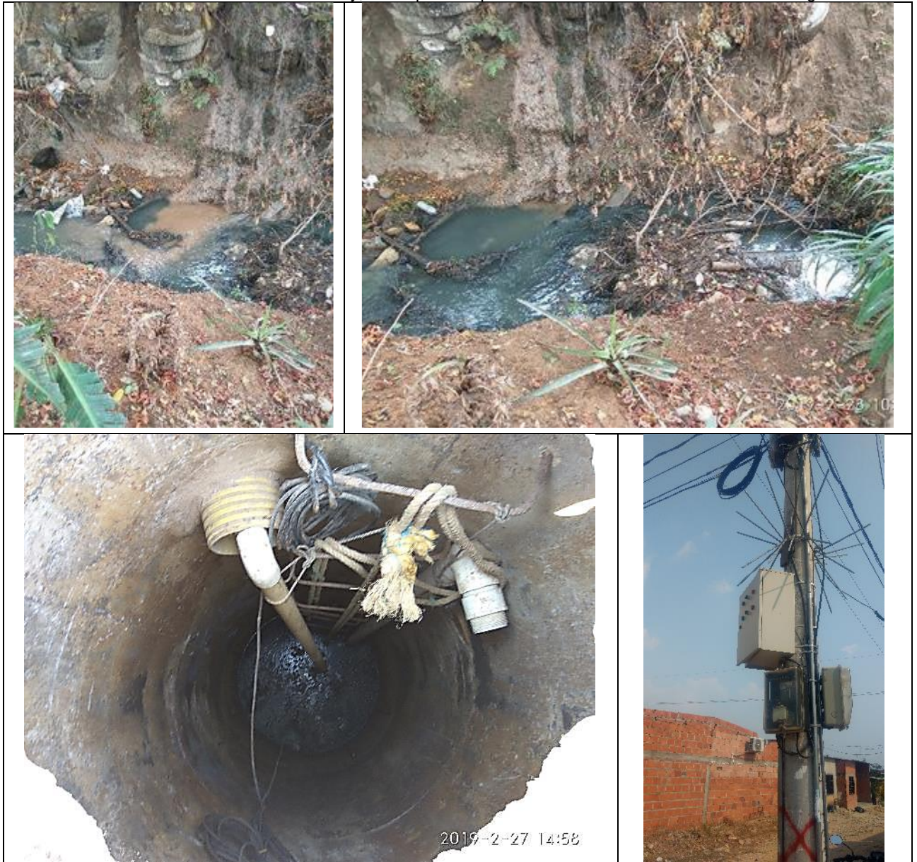
Fuente: Visita de inspección
