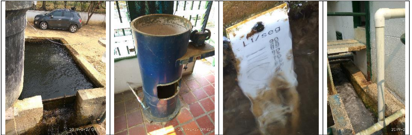
Imagen 9. Se ilustra las etapas de la PTAP: cámara de quietamiento, dosificador de coagulante, regleta de aforo (para un caudal máximo de 90 L/s, claramente superado), canal de entrada, floculador, sedimentador, filtros, tanque de inyección de desinfectante y caseta de cloración. Por último, signos de deterioro en la infraestructura.
