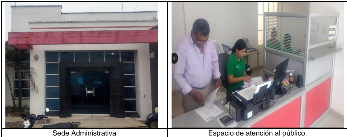
Imagen 42 Sede del Prestador APCES
