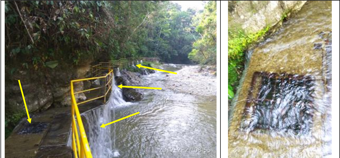
Imagen 7. Aducción y tanque desarenador construidos sobre la margen izquierda de la Quebrada Torcoroma. Se ilustra el camino peatonal hasta el desarenador, el rebose de excesos y el estado de la estructura del desarenador a la fecha de la visita.
