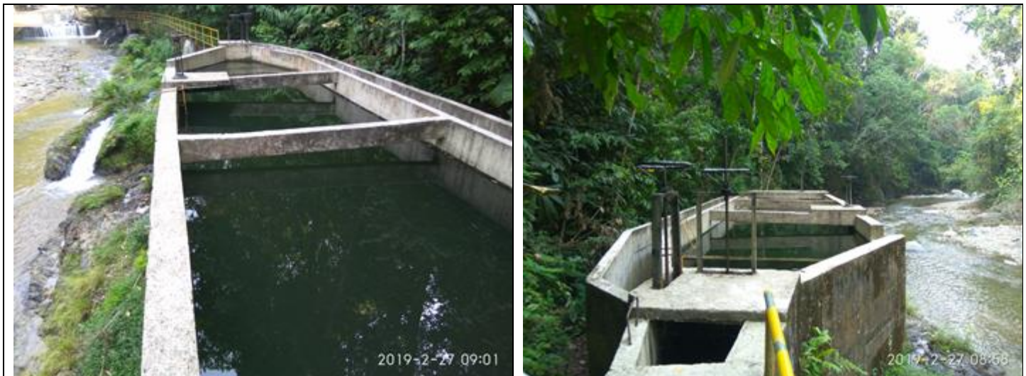
Imagen 7. Aducción y tanque desarenador construidos sobre la margen izquierda de la Quebrada Torcoroma. Se ilustra el camino peatonal hasta el desarenador, el rebose de excesos y el estado de la estructura del desarenador a la fecha de la visita.
