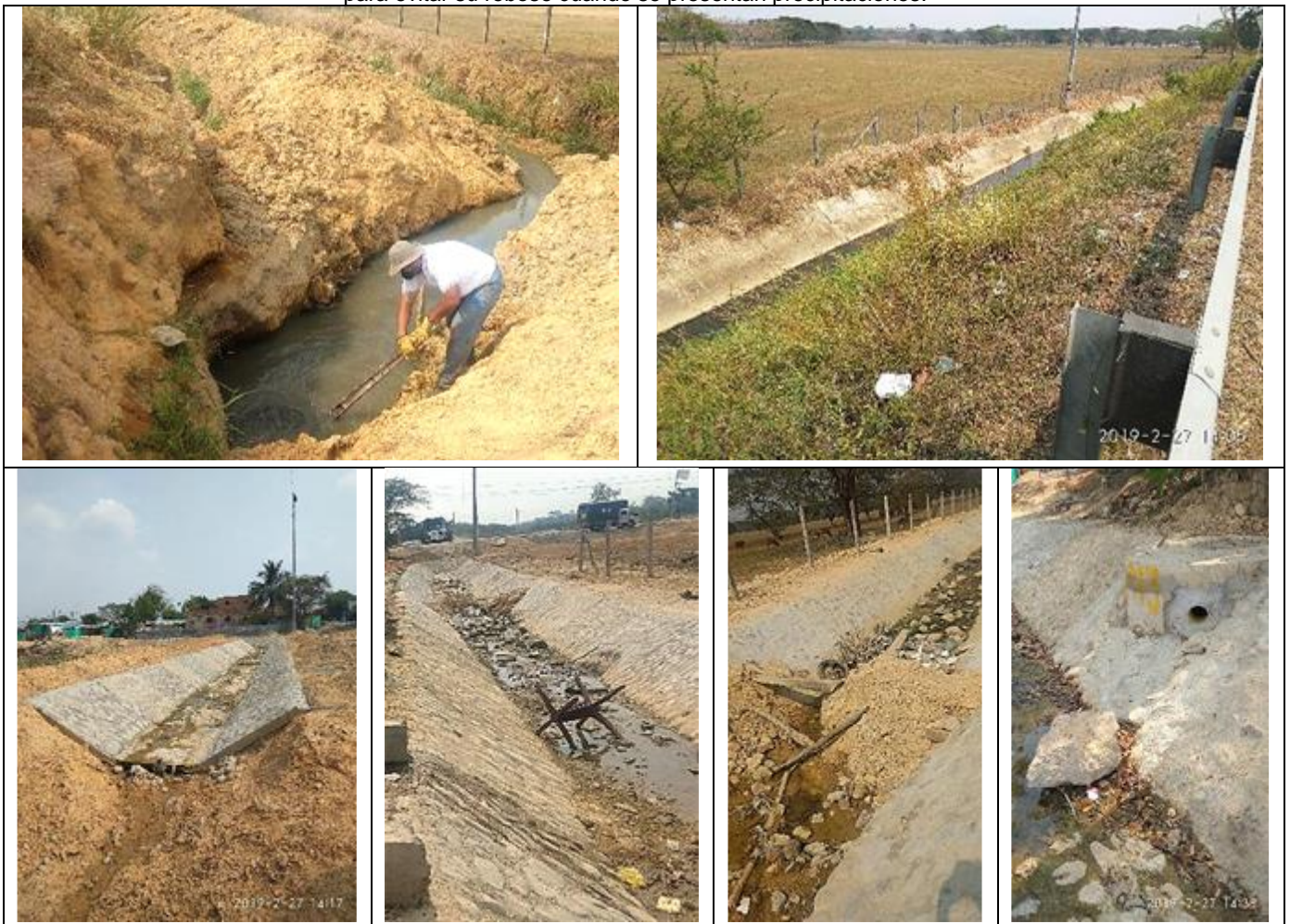
Fuente: Visita de inspección
