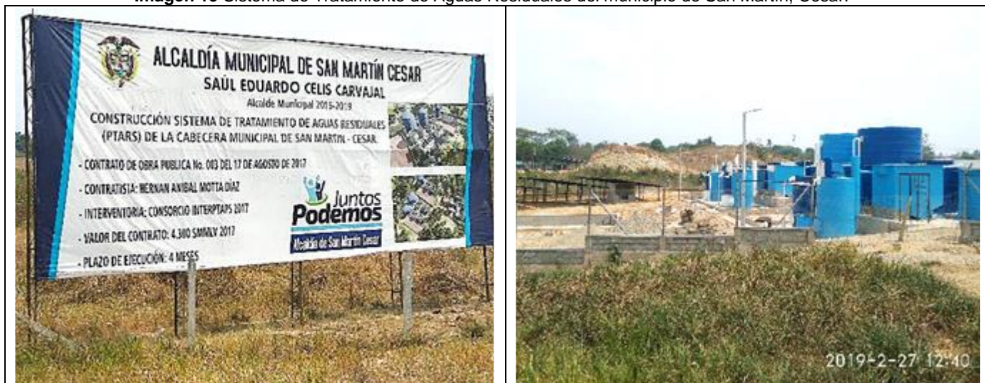
Imagen 19 Sistema de Tratamiento de Aguas Residuales del municipio de San Martín, Cesar.
