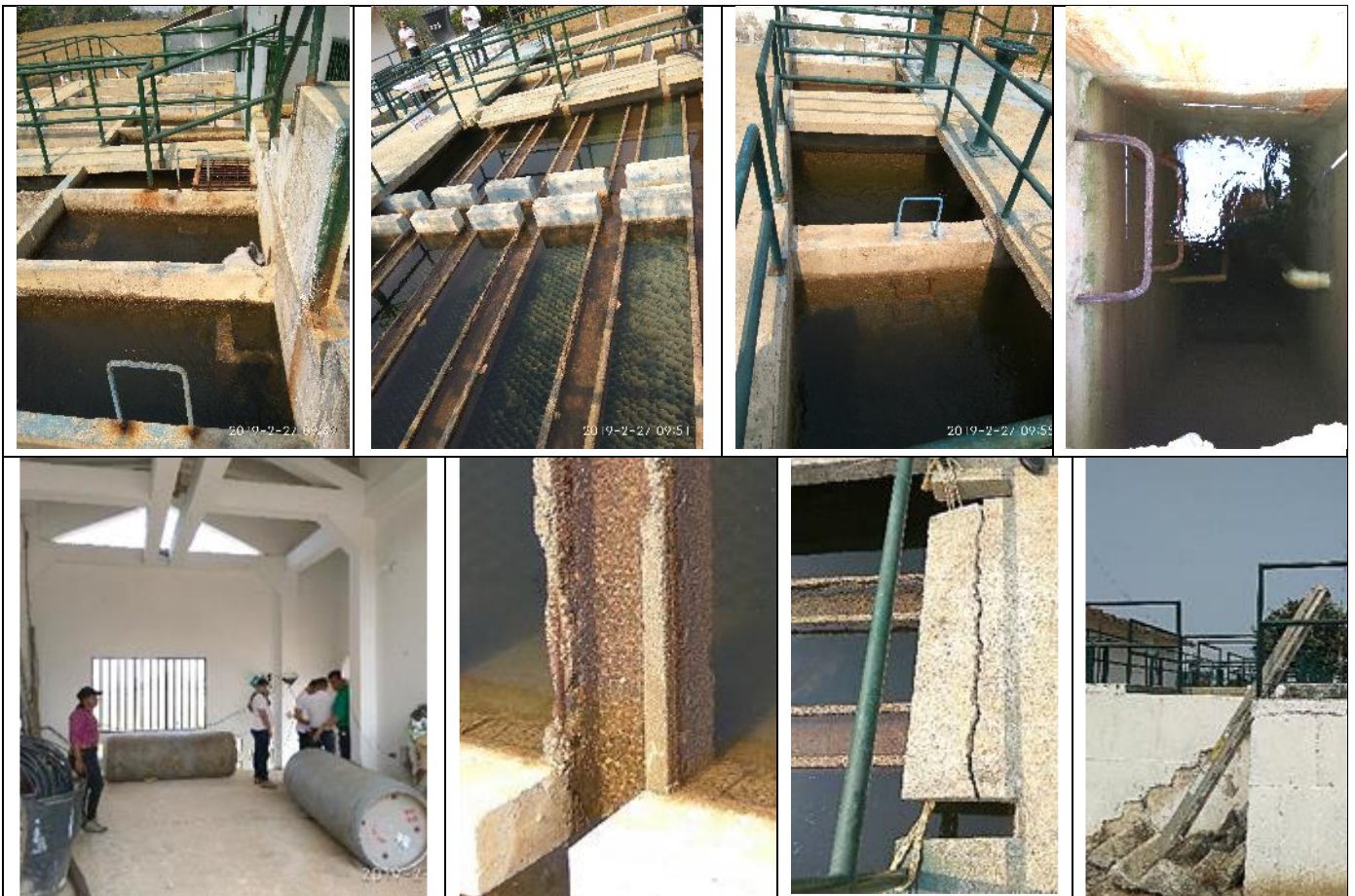
Imagen 9. Se ilustra las etapas de la PTAP: cámara de quietamiento, dosificador de coagulante, regleta de aforo (para un caudal máximo de 90 L/s, claramente superado), canal de entrada, floculador, sedimentador, filtros, tanque de inyección de desinfectante y caseta de cloración. Por último, signos de deterioro en la infraestructura.
