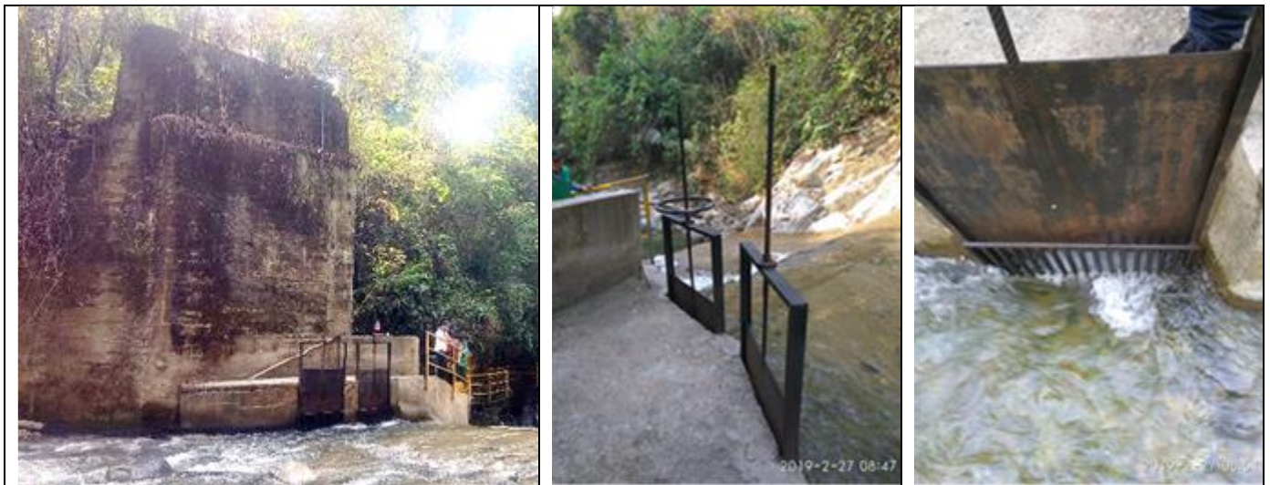
Imagen 6. Bocatoma Quebrada Torcoroma, en la vereda El Cairo de San Martín, Cesar. Se ilustra su localización, la única valla informativa, su estructura y las compuertas y rejilla laterales.
