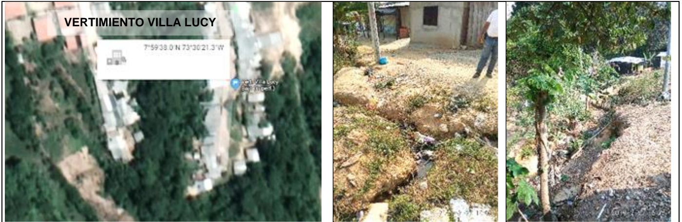
Fuente: Visita de inspección
