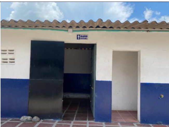
Vestidores e instalaciones sanitarias
