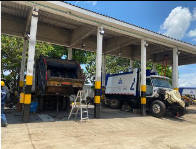
Zona de mantenimiento
