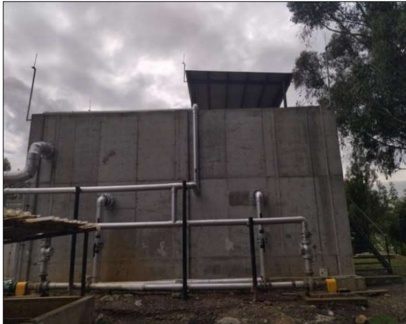
Imagen 4. Tanque de homogenización (Izquierda) y Clarificadores de alta tasa (derecha)
