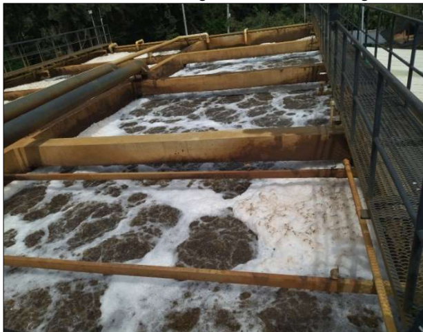
Imagen 5. Reactor Biológico con aireación extendida (biosoportes)
