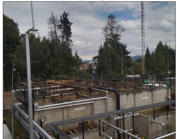
Imagen 5. Reactor Biológico con aireación extendida (biosoportes)
