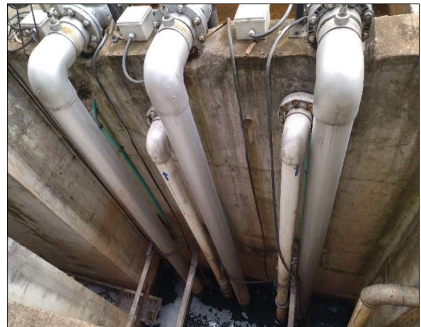
Imagen 3. Cárcamo de bombeo (izquierda) y sistema de bombas sumergibles (derecha)
