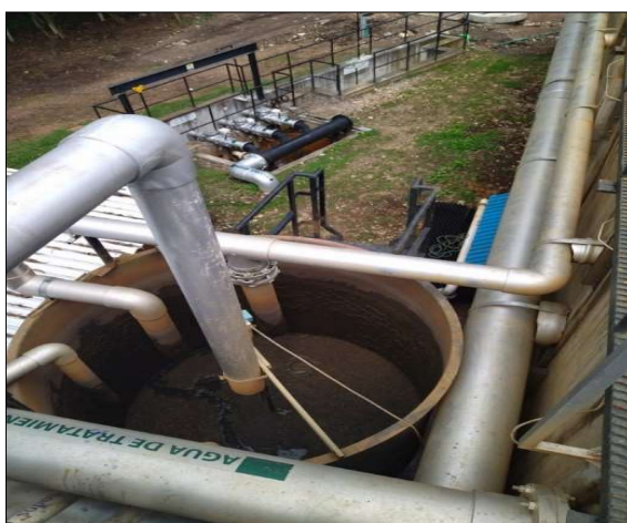
Imagen 11. Tanque mezcla de lodos (izquierda) y Swingmill (derecha)
