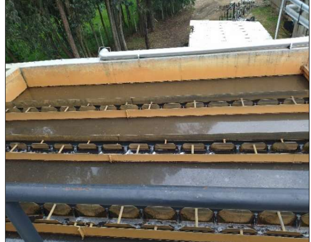
Imagen 4. Tanque de homogenización (Izquierda) y Clarificadores de alta tasa (derecha)
