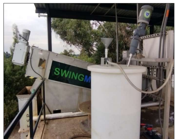
Imagen 11. Tanque mezcla de lodos (izquierda) y Swingmill (derecha)
