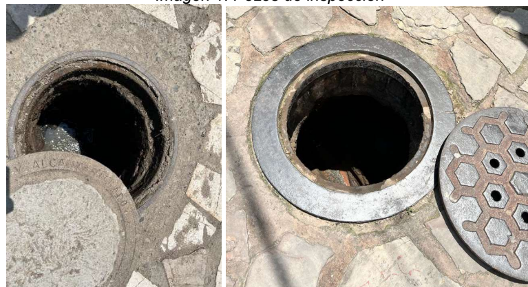
Imagen 1. Pozos de inspección
