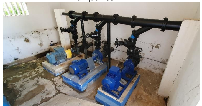
Estación de rebombeo
