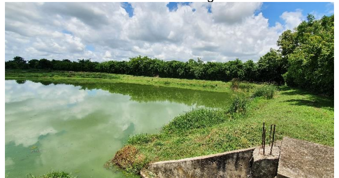
Presencia de material vegetal
