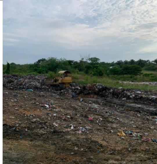
Registro fotográfico- compactación
